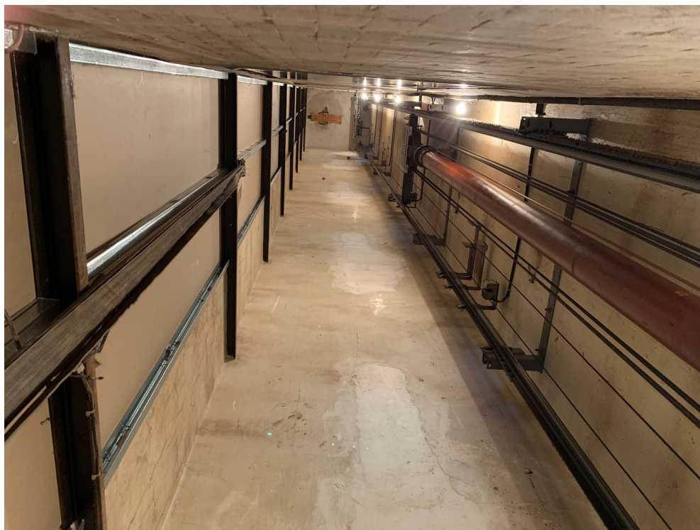
Vista interior del buc de l'ascensor.
