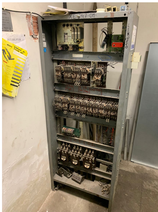
Detall de la maniobra de relés d'origen.
