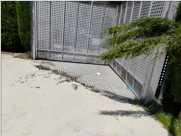
13. PORTA DOBLE D'ACCÉS AL CAMP PEL CARRER DEL PI
