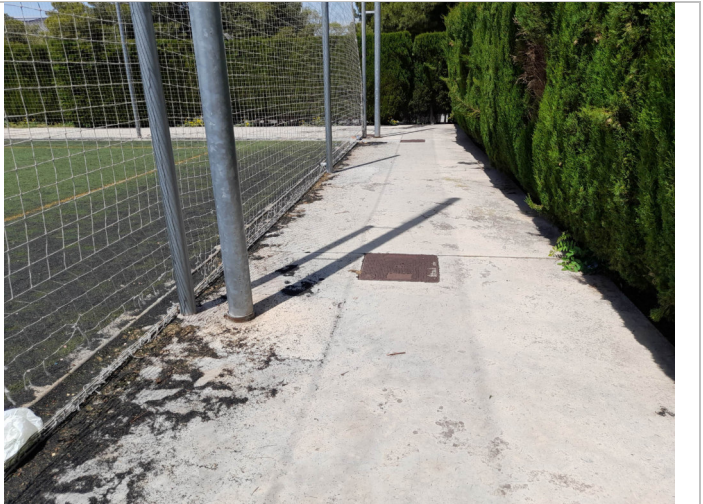
Detall del muntant de la barana foradat per les fixacions de les tanques publicitàries.
