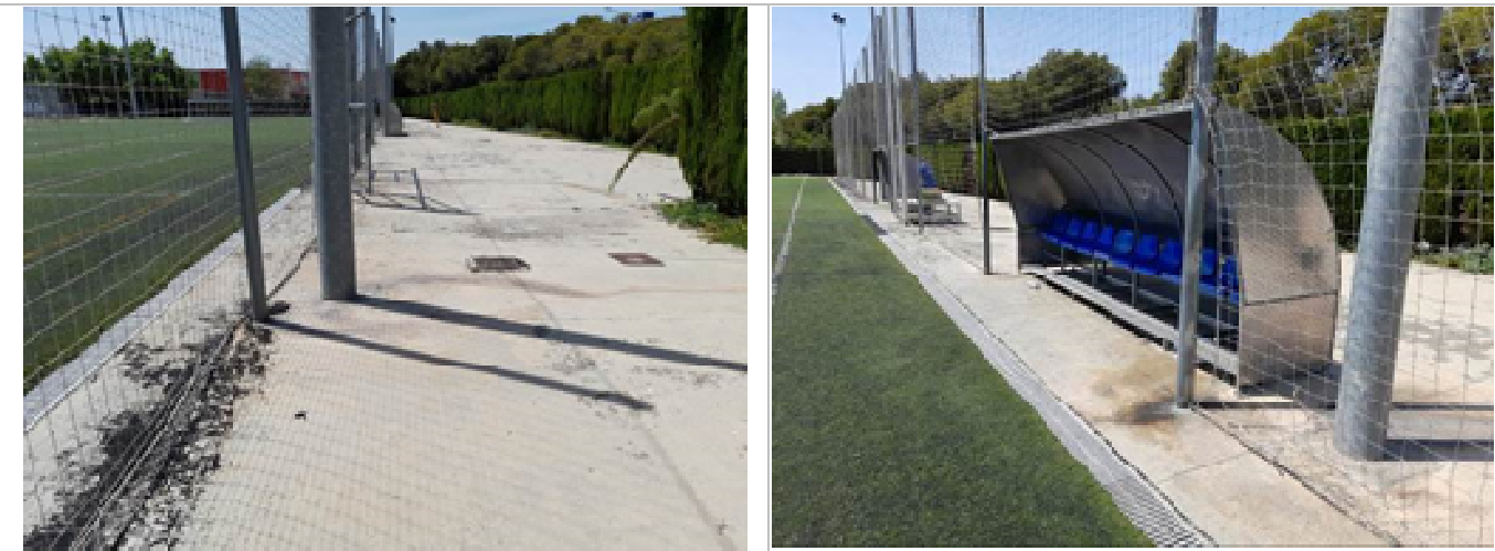
Detall de l'estat de la xarxa para-pilotes, dels perímetres del paviment de formigó, de la gespa i dels bancs de jugadors
