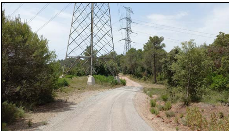
Imatge 2. Final del tram pavimentant actual, en el que aquest present any 2022 es realitzaran 325 més de paviment, punt en el que s'iniciaran els treballs definits en el present projecte.
