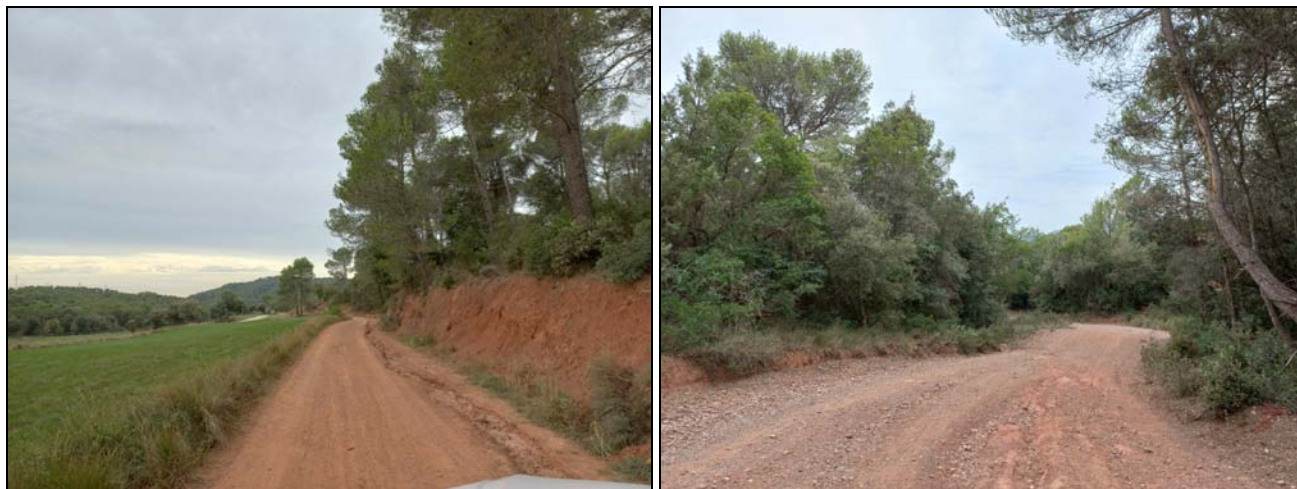
Imatge 1. Trams a pavimentar. La primera imatge en el seu tram final, on s'aplicarà TTS. En la segona imatge, tram amb major pendent, on es realitzarà el paviment amb aglomerat asfàltic.
