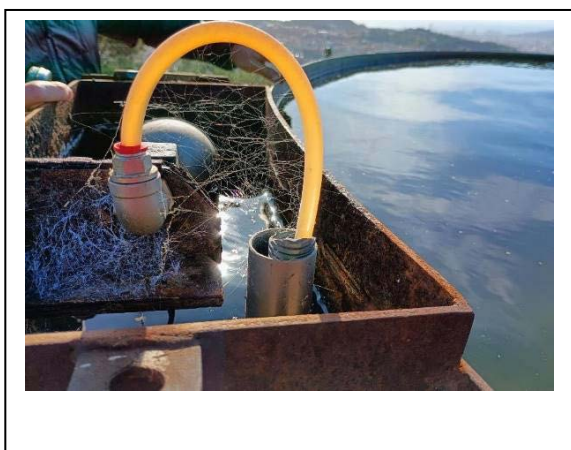
Imatge 23: Exemple del sistema d'abastiment automàtic amb boia de control
