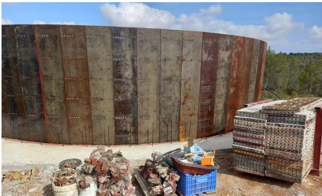
Imatge 22: Exemple d'encofrat en el punt d'aigua d'Avinyonet (PPP Garraf).
