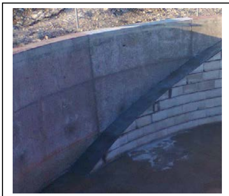
Imatge 30: Rampa de fauna d'obra per punt d'aigua.
