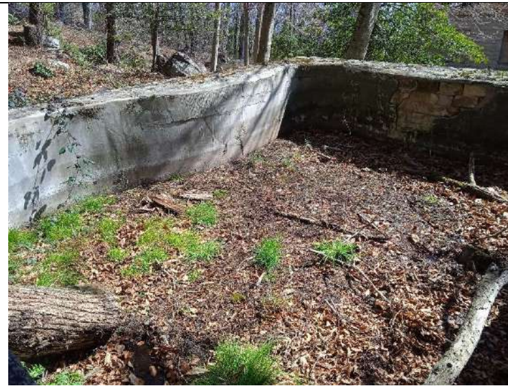
Bassa gran. Neteja, repicat i impermeabilització de bassa. Construcció d'una rampa antiofegament per a fauna
