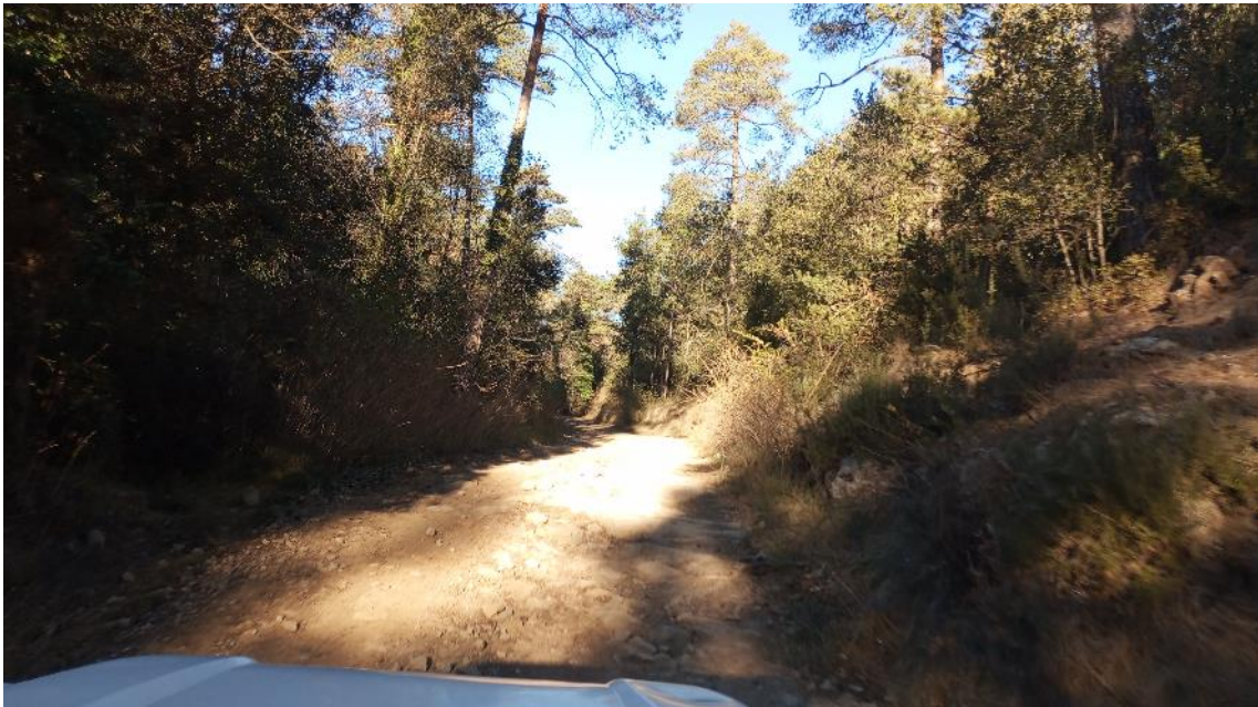
Estat actual del camí 02-IV
