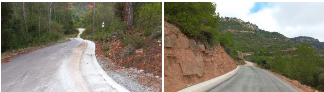
Imatge 3: Imatges dels últims treballs previs executats.
