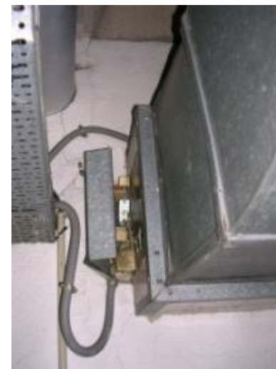
042 Comportes tallafocs conductes
