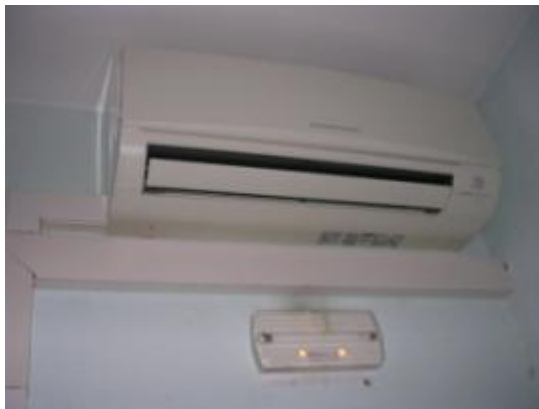
002 antic despatx restauració P3 Gardunya
