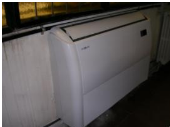
072 Magatzem gravats dreta
