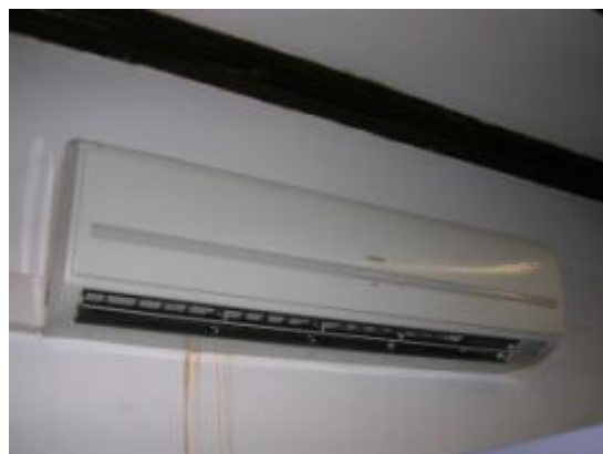
120 Sala Servidors ATI costat dret
