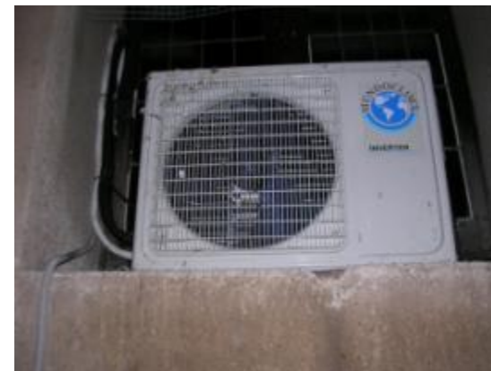
068 Condensadora corresponent a foto 066
