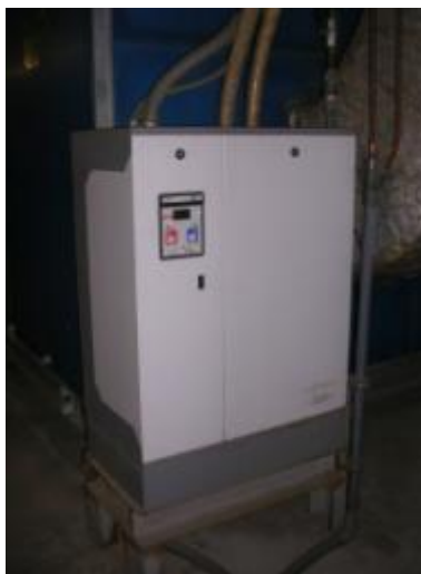
026 Humidificador france AIR CRH40
