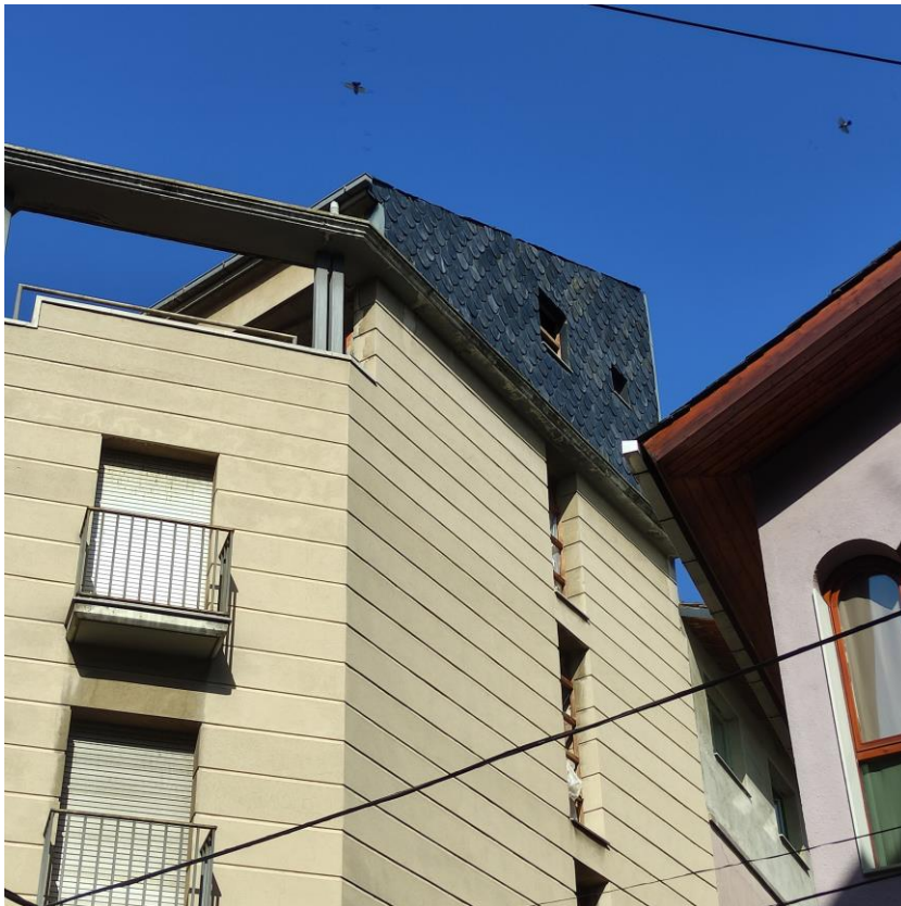
Fotografia façana nord-est. Part superior ( A Carrer de la Muralla)
