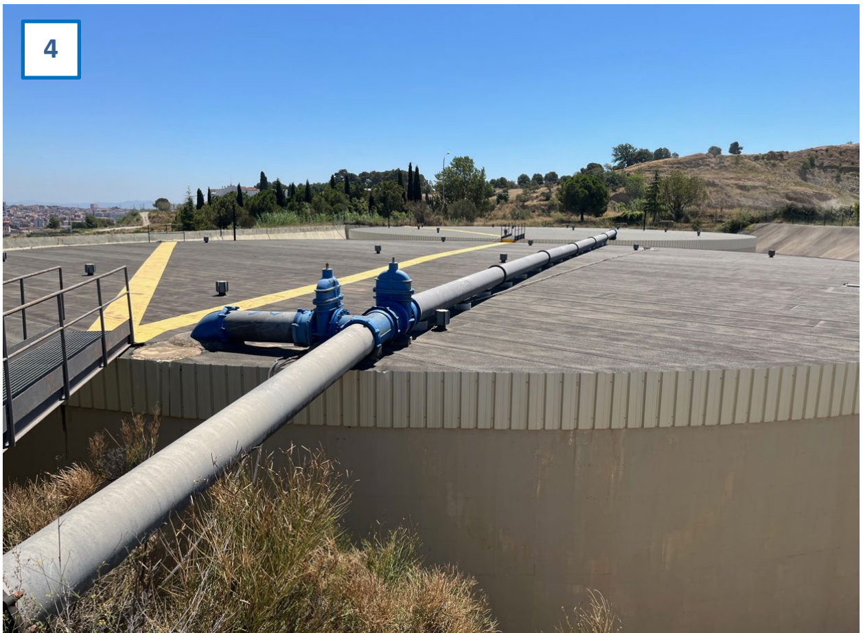
Imatge 4. Vista coberta dipòsits
