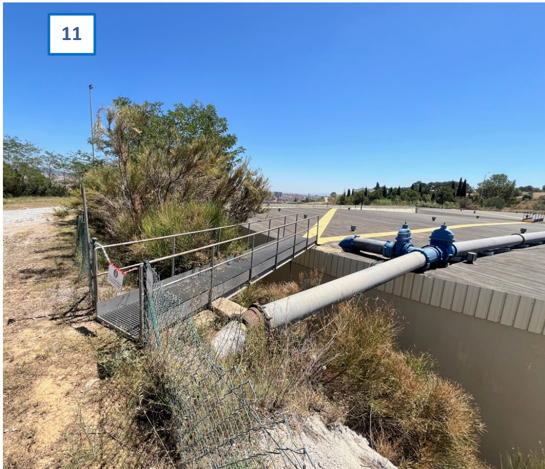
Imatge 11. Passarel·la accés a coberta dipòsits des de parterre
