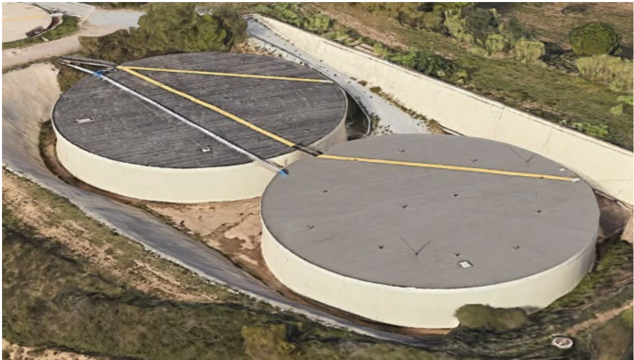
Imatge de la coberta on s'ha previst la instal·lació
