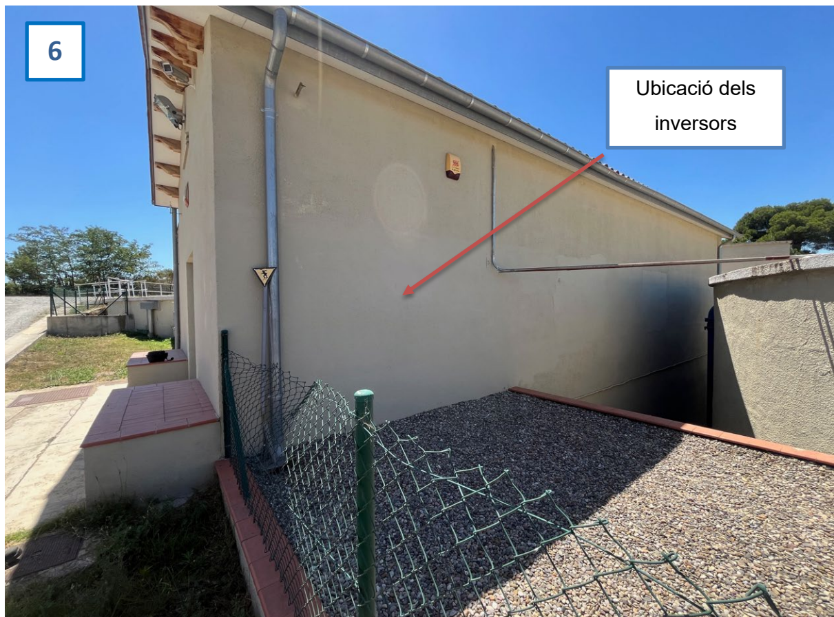
Imatge 6. Ubicació inversors
