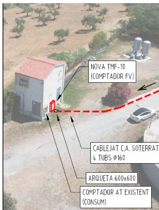
Escomesa exterior TMF10 de generació en façana CT
