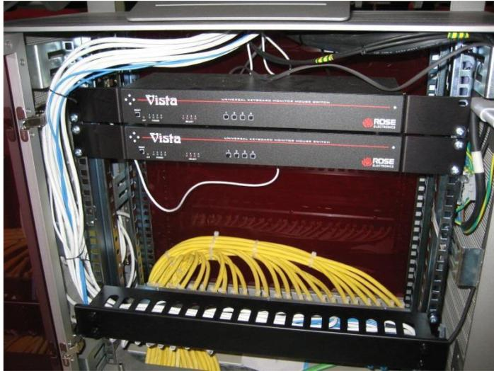
Bandeja basculante para instalar receptor KVM.
