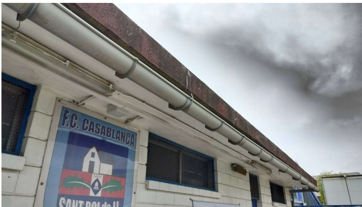
Vista de canal i coberta a reparar
