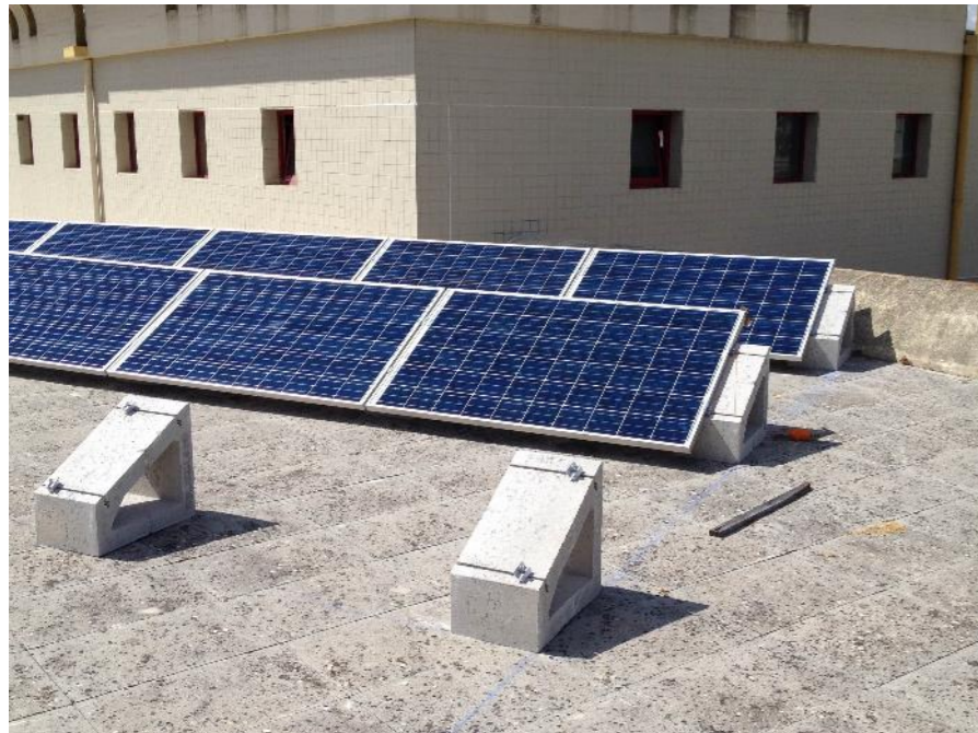
Sistema de fixació dels mòduls SOLARBLOC
