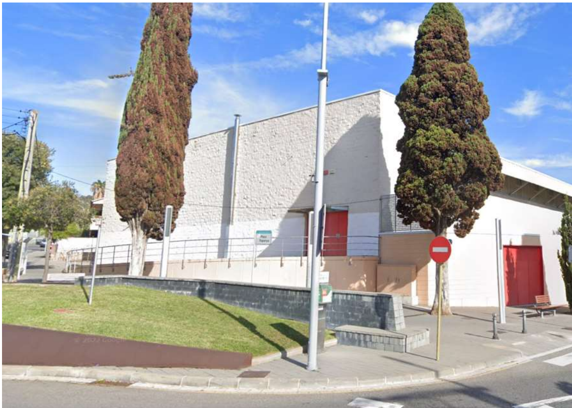
Imatge 5. Paret exterior però baixarà el cablejat DC
