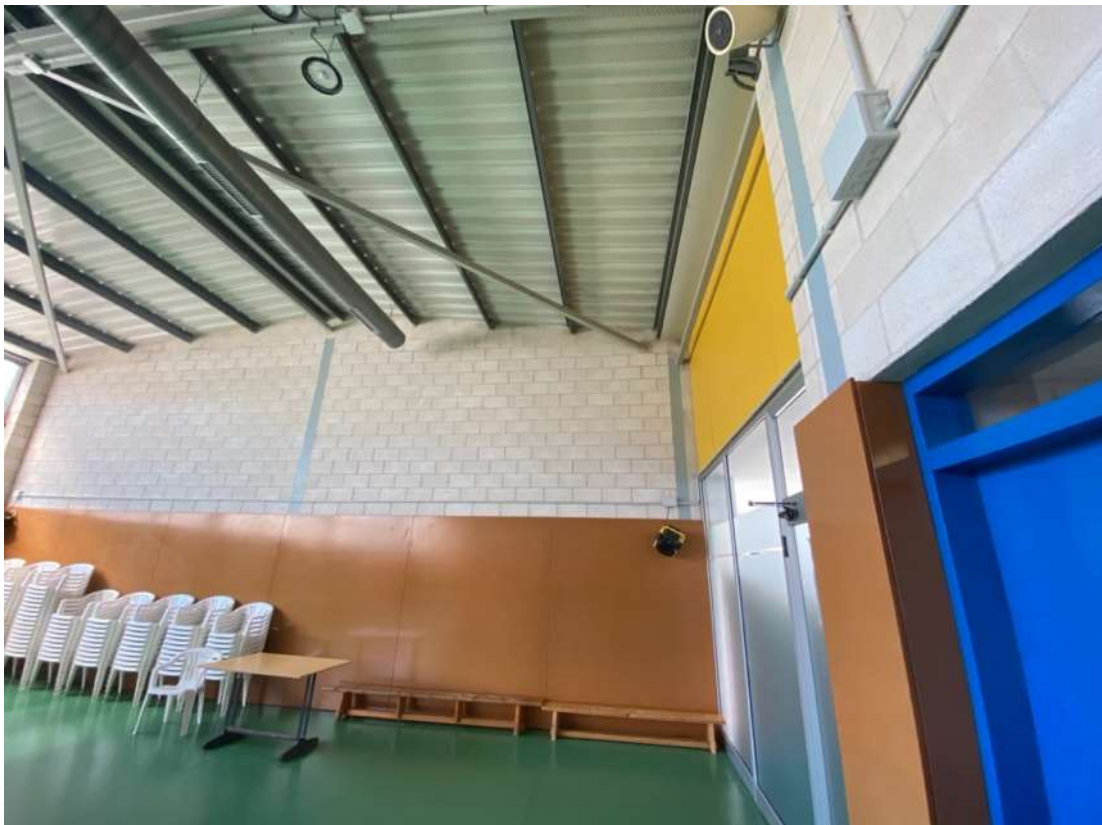
Imatge 7. Paret interior ubicada al darrere del punt de connexió
