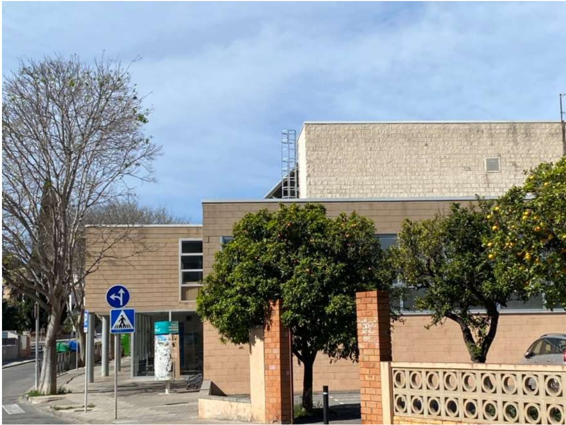
Imatge 8. Escala de gat existent
