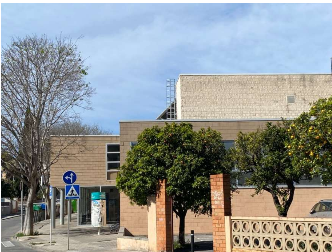
Taula 9.1. Escala de gat existent a la cantonada sud-est del edifici
