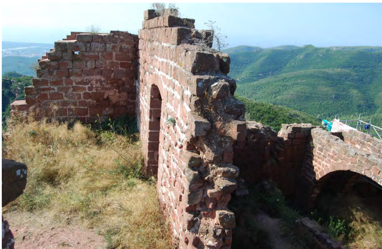
Imatge amb la planta primera de l'àmbit D a l'esquerra i l'interior de l'àmbit C a la dreta. 29/JUL/2020 (E. Píriz).
