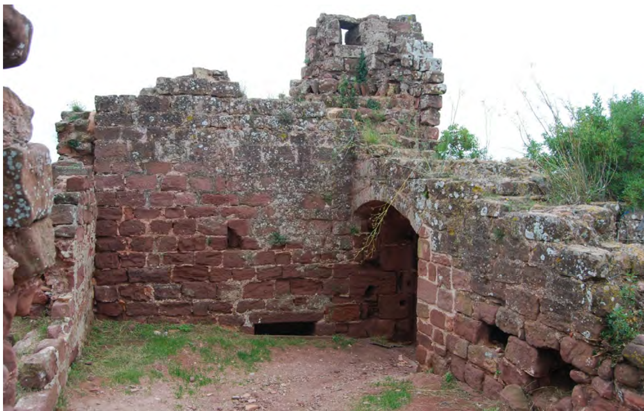
Fotografia de l'interior de l'àmbit B amb el portal a la dreta. 9/OCT/2020 (E. Píriz).
