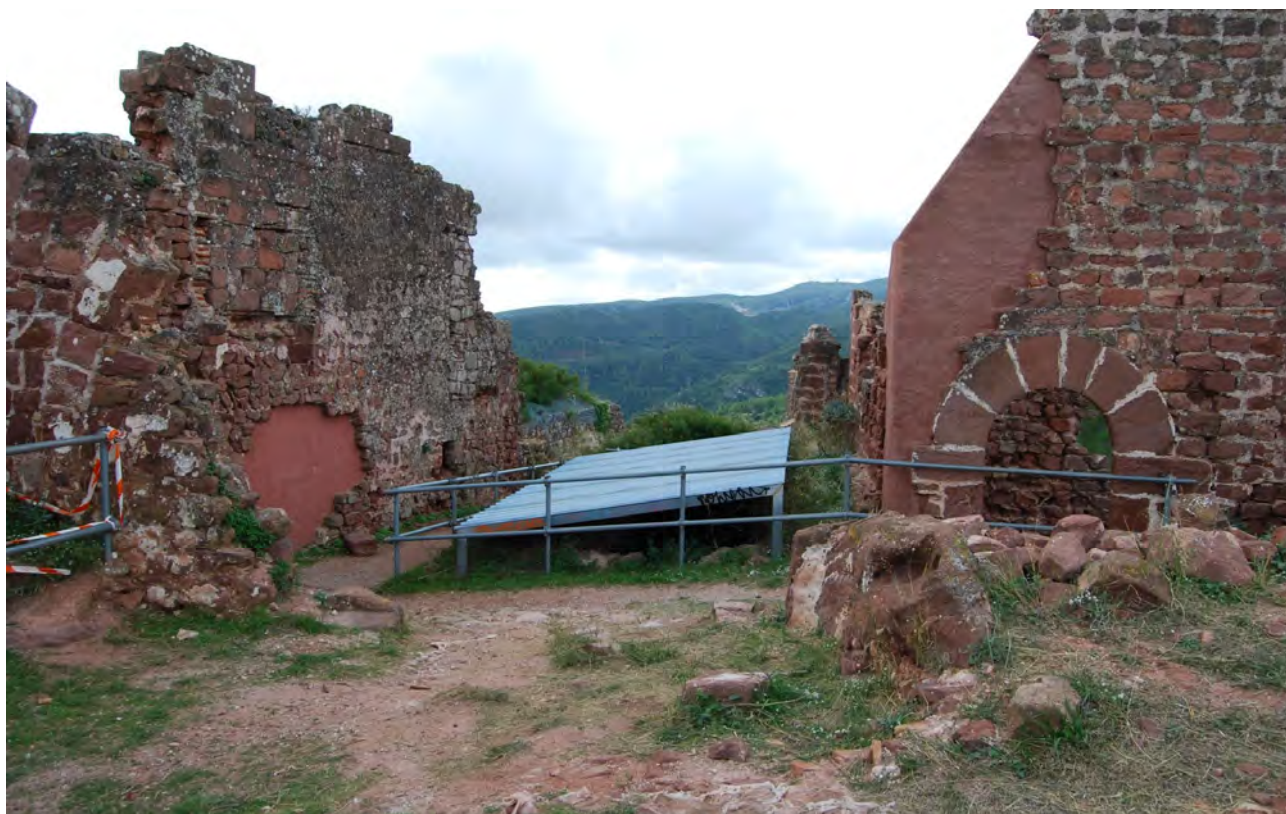
Fotografia de l'àmbit H (pati) amb la cisterna coberta amb xapa metàl·lica, on es pot veure l'edifici àmbit G a la dreta i l'edifici àmbit C a la dreta. 20/OCT/2020 (E. Píriz).
