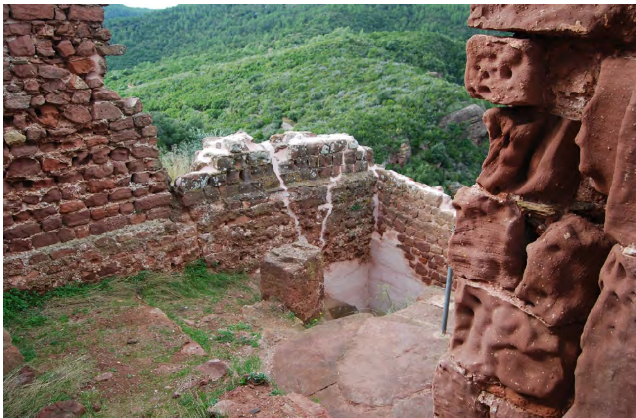
Fotografia de l'interior de l'edifici àmbit G. 1/MAI/2024 (E. Píriz).
