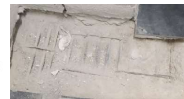
Figura DP1.1 Cala cara superior tram biga CJS1 en sostre planta soterrani
