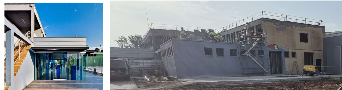
Figura HA.1. Imatges del cos de l'edifici del poliesportiu objecte de la diagnosi.
