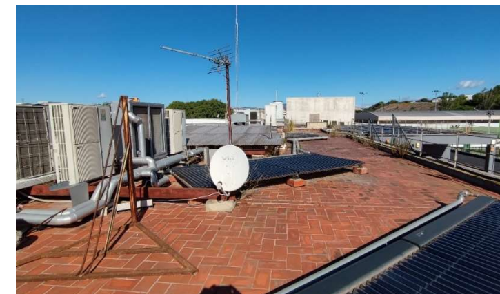
Figura DE.3.2. Vista de la coberta plana de la planta primera.
