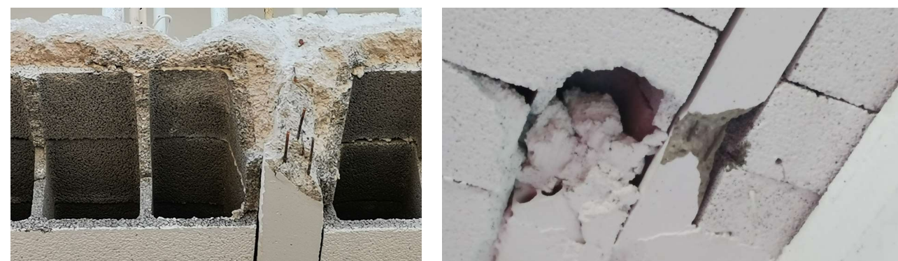
Figura DP1.9 Imatge del cantell del sostre unidireccional presa durant l'enderroc de la fase 1 (esquerra) i de la cala CB1 (dreta) on es poden observar les biguetes autoportants pretesades que formen el sostre.
