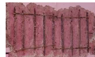
Figura DP1.2 Cala cara inferior tram biga CJI1 en sostre planta soterrani
