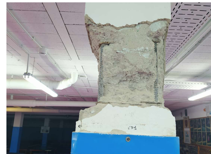
Figura AS.3.5.3. Imatge de la cala CP1 on es pot veure la diferència de recobriment entre cares del pilar.
