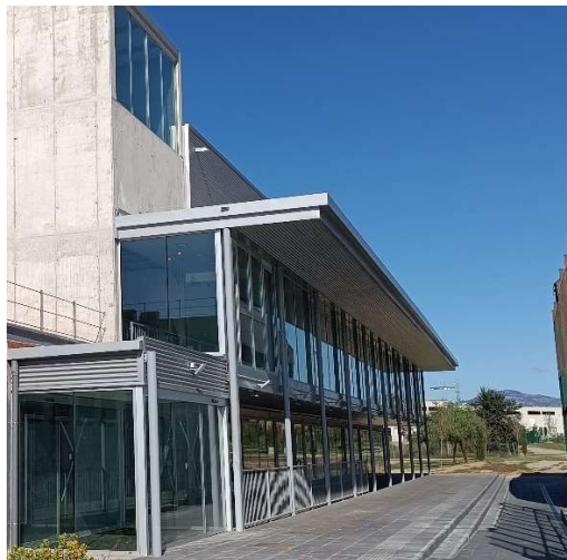
Figura HA.3. Imatge de l'edifici acabat (fase 1) on es poden veure els materials utilitzats.
