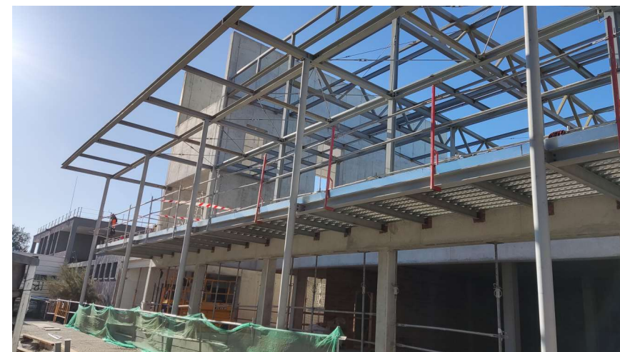
Figura HA.2. Imatges del cos de l'edifici del poliesportiu objecte de la diagnosi.
