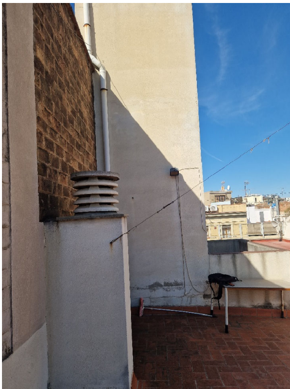
Vista mitgera nord i caixa d'ascensor
