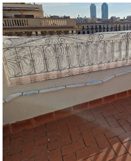
Coberta COMERÇ - barana
