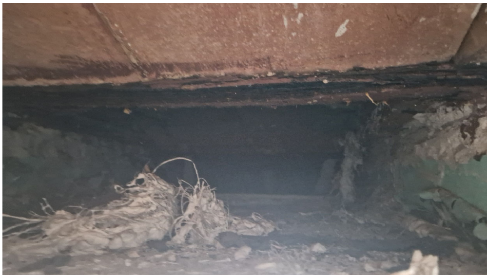
3-1 Sostre de la galeria
