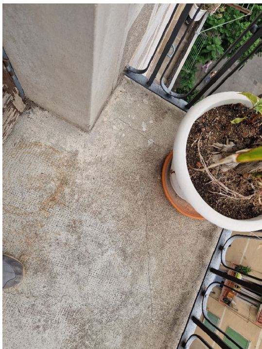
Vista inferior del balcó
