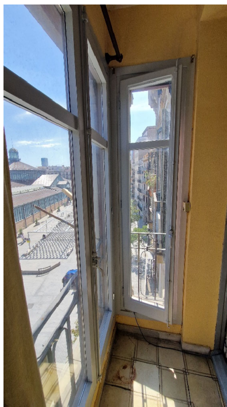
4.1- Fusteries lateral galeria
