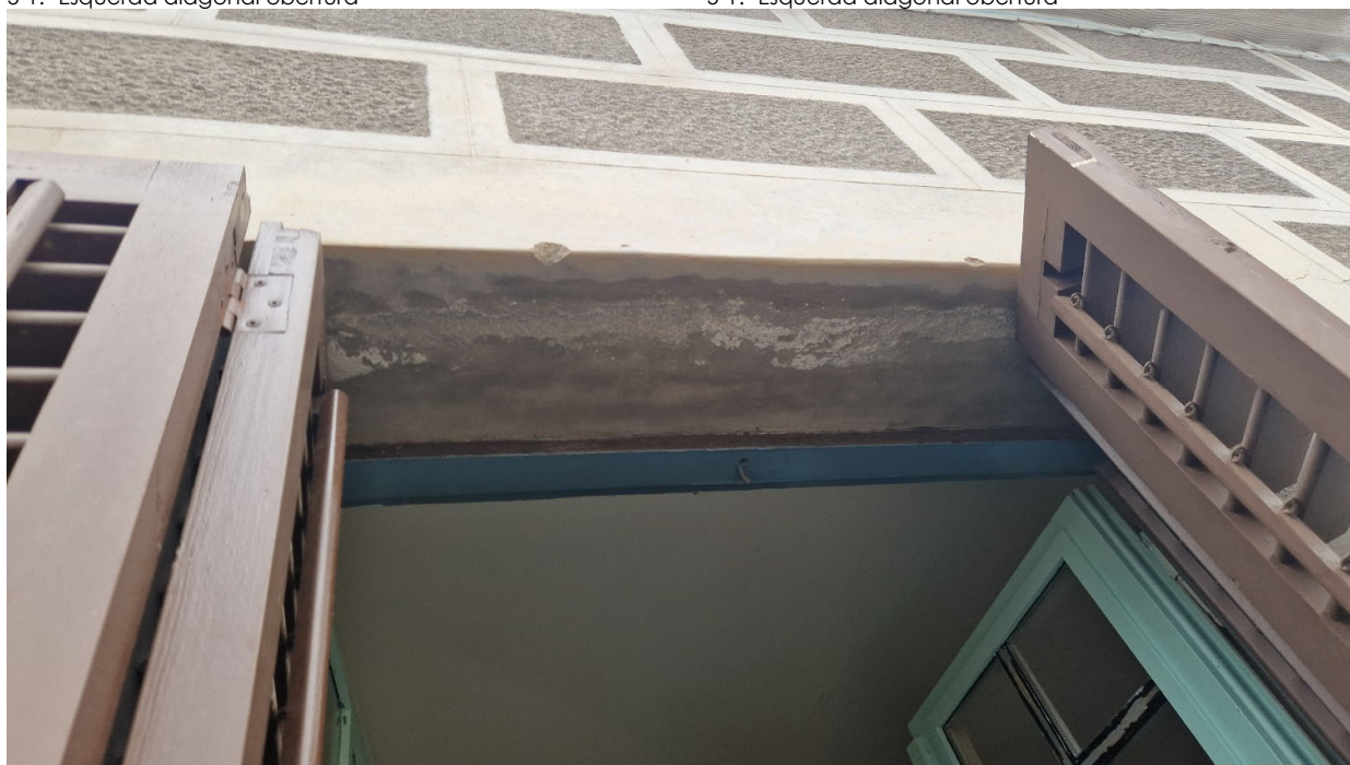
5.1.- Rastres humitats dintells Falta de goteró
