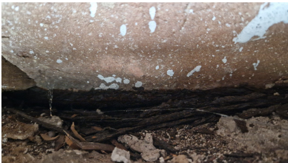
3-1 Detall de la bigueta del sostre de la galeria
