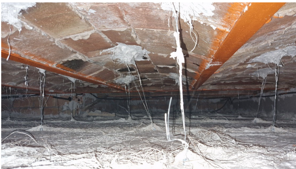
3-1 Vista general forjat des de façana Comerç, 1er tram, biguetes perpendiculars a façana i després paral·leles.
