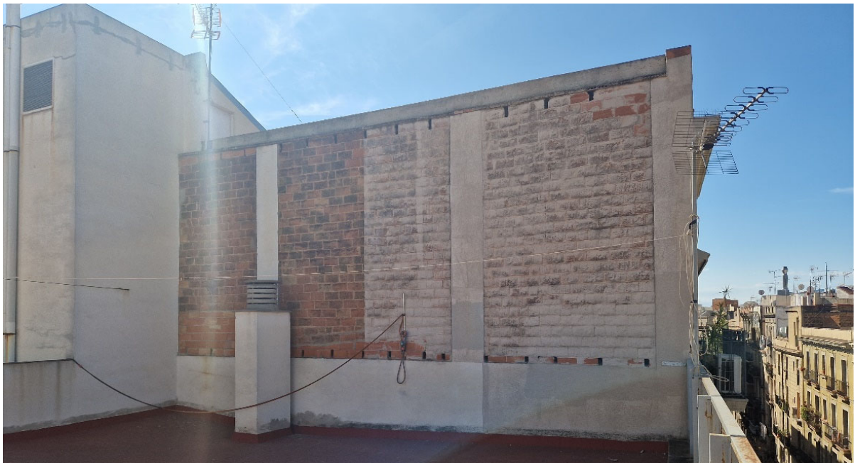
Vista mitgera nord des del terrat de la finca del C/ del Comerç 52
