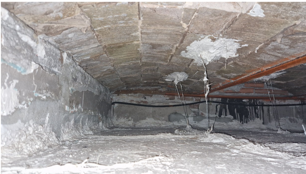
5-2 Imatge on es veu biguetes paral·leles a façana i platina de lligadura perimetral
