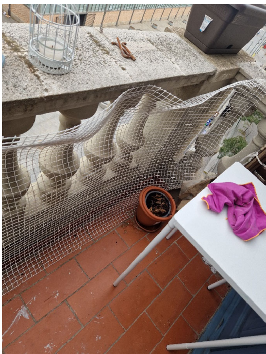
5-1 - Vista paviment balcó
