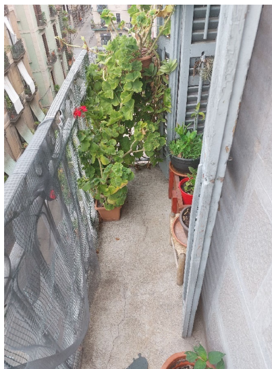
Vista inferior del balcó
