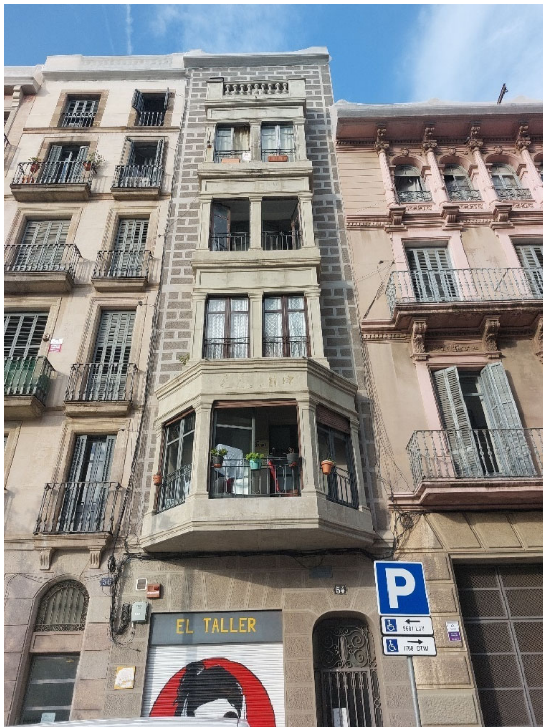
Vista de façana exterior i galeria
