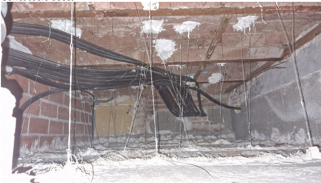
Cel·ràs sobre vestíbul (espai comptadors elèctrics)
