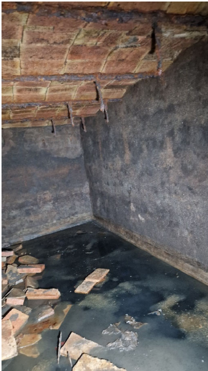
Vista inferior del forjat a enderrocar
