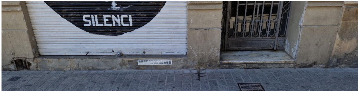
Reixa de ventilació a eliminar
