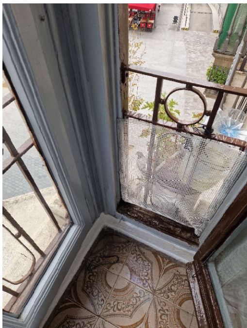
2.1- Fusteries lateral galeria
