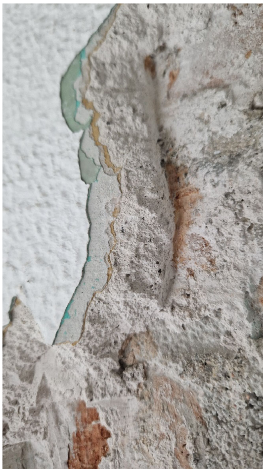
Acabat de façana a l'interior de la galeria, amb morter de calç i capes de pintura afegida. (3 er -1 a )
