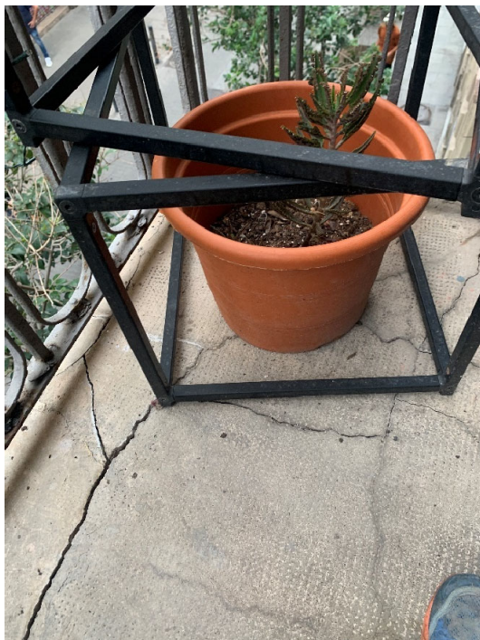
Esquerdas en revestiment
