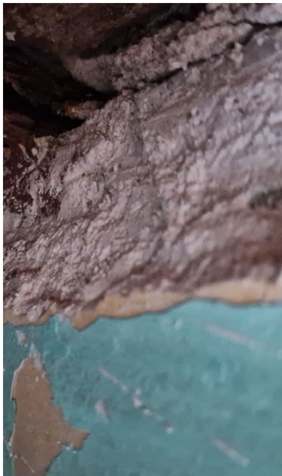
Acabat de façana a l'interior de la galeria, amb morter de calç i capes de pintura afegida. (3 er -1 a )
