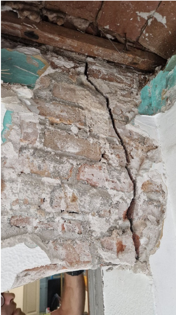
3-1 Esquerda dintell repicada. Dintell d'obra en arc.
