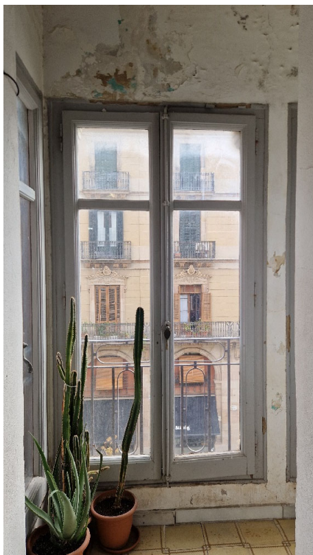
Comerç (3º-1ª) – Fusteries lateral galeria
