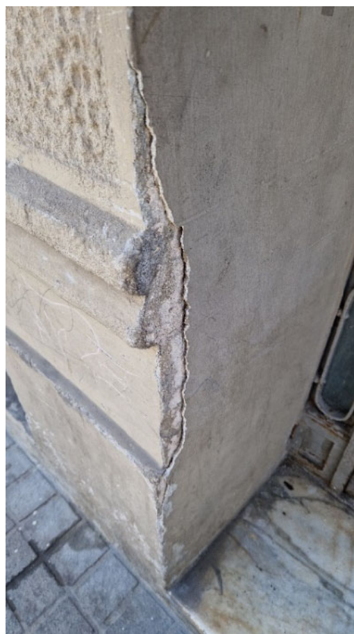
Detall revestiment PB C/Comerç
