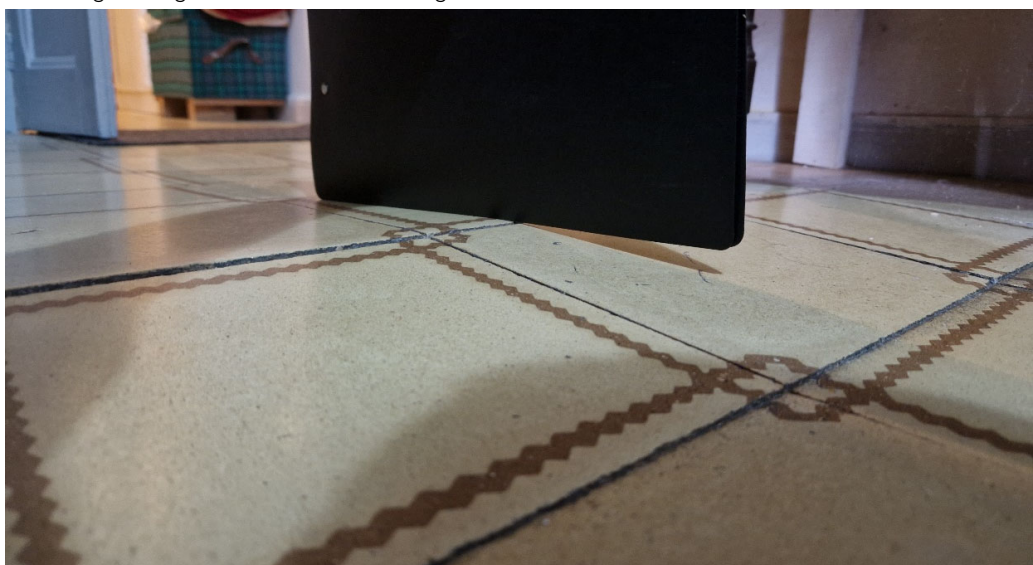
Vista general forjat 2-1 i els bombaments paral·lels a façana
