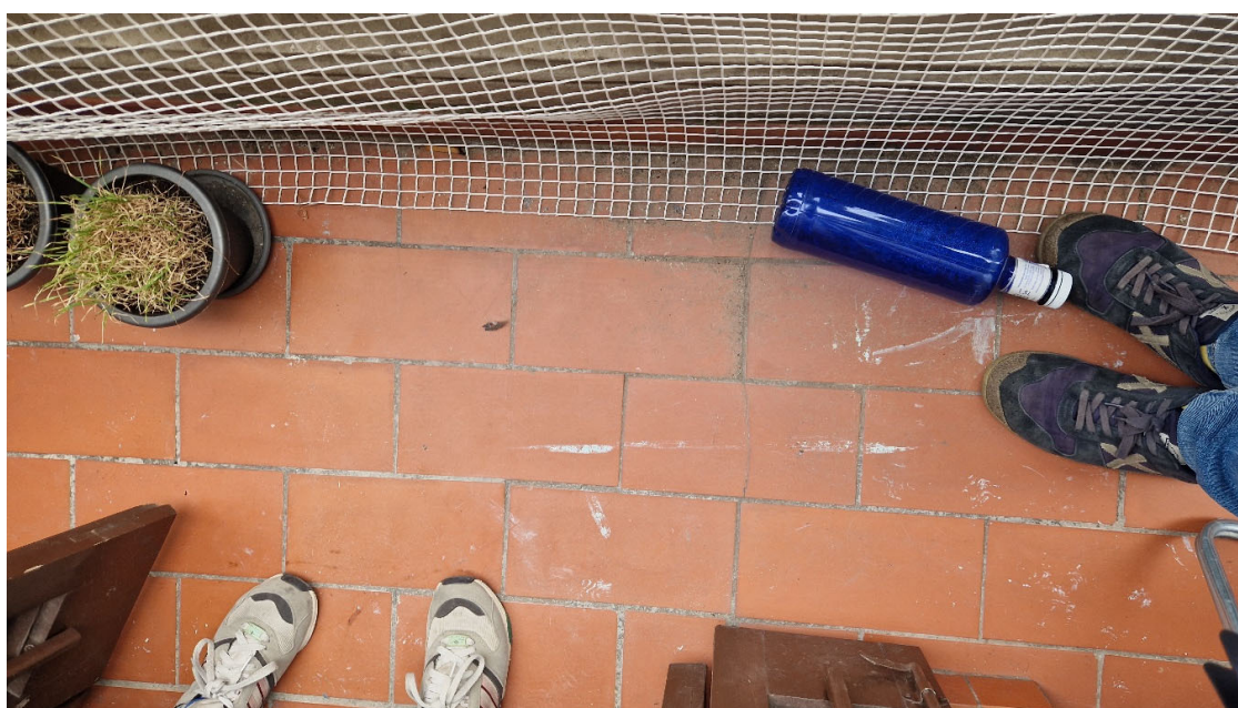
5-1 - Vista paviment balcó
