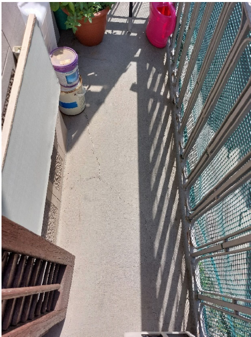
3-2.- Detall barana lateral
