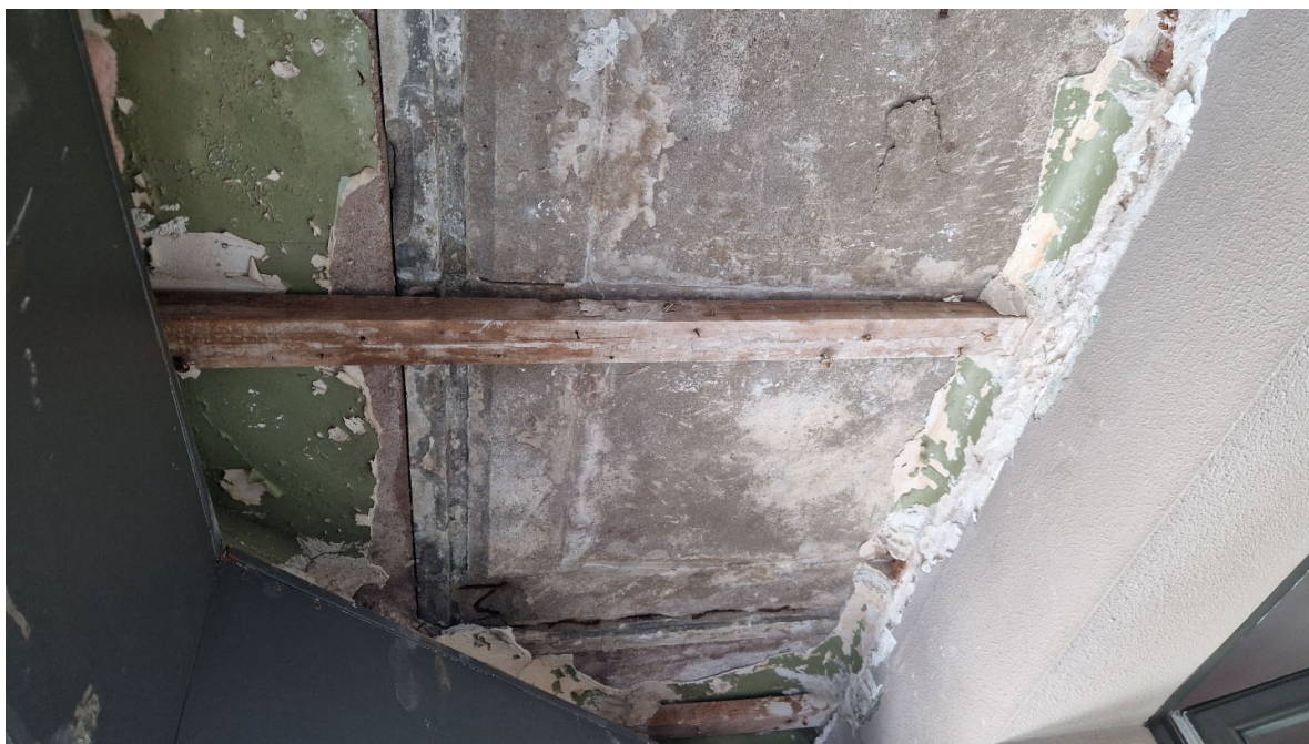
Sostre de la tribuna del 1-1, on es veu la llosa de formigó prefabricat i el recrescut de formigó
