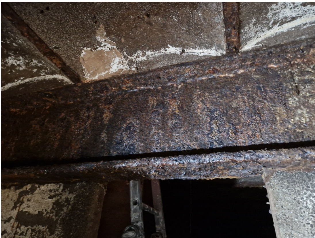
Vista soterrani -1 i estat de les jàsseres
