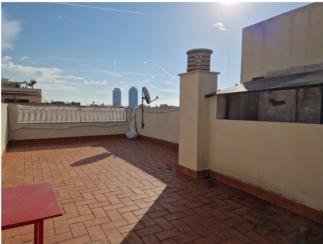
Vista general de la coberta c/ del Comerç
