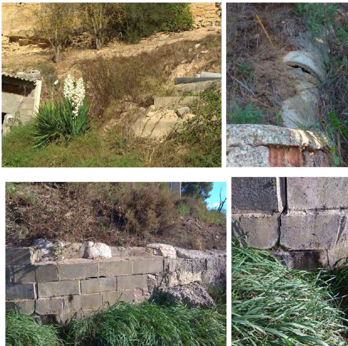
Imatges estat actual del tram de col·lector de la Feixa del Gat
