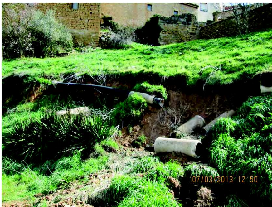
Imatge del tram de canonada ensorrat després d'una primera reparació d'urgència
