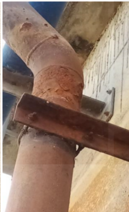
Figures 3 i 4. Vista de detall de l'estat d'un dels baixants i dels abarcons de suport.
