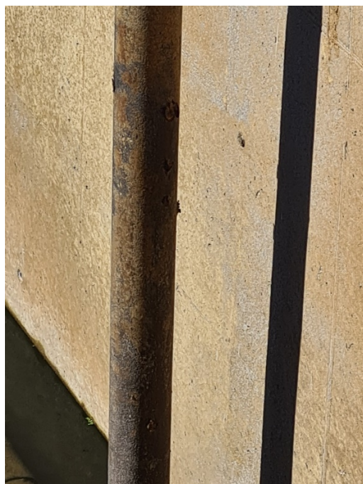
Figures 3 i 4. Vista de detall de l'estat d'un dels baixants i dels abarcons de suport.
