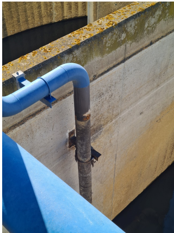
Figures 1 i 2. Vista de l'estat dels baixants, en concret la part que queda submergida quan estan en servei.
