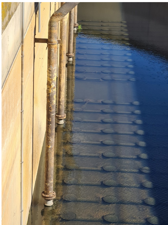
Figures 1 i 2. Vista de l'estat dels baixants, en concret la part que queda submergida quan estan en servei.
