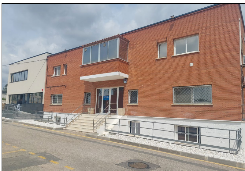
Façanes Edifici Nou i Edifici Vell del Laboratori
