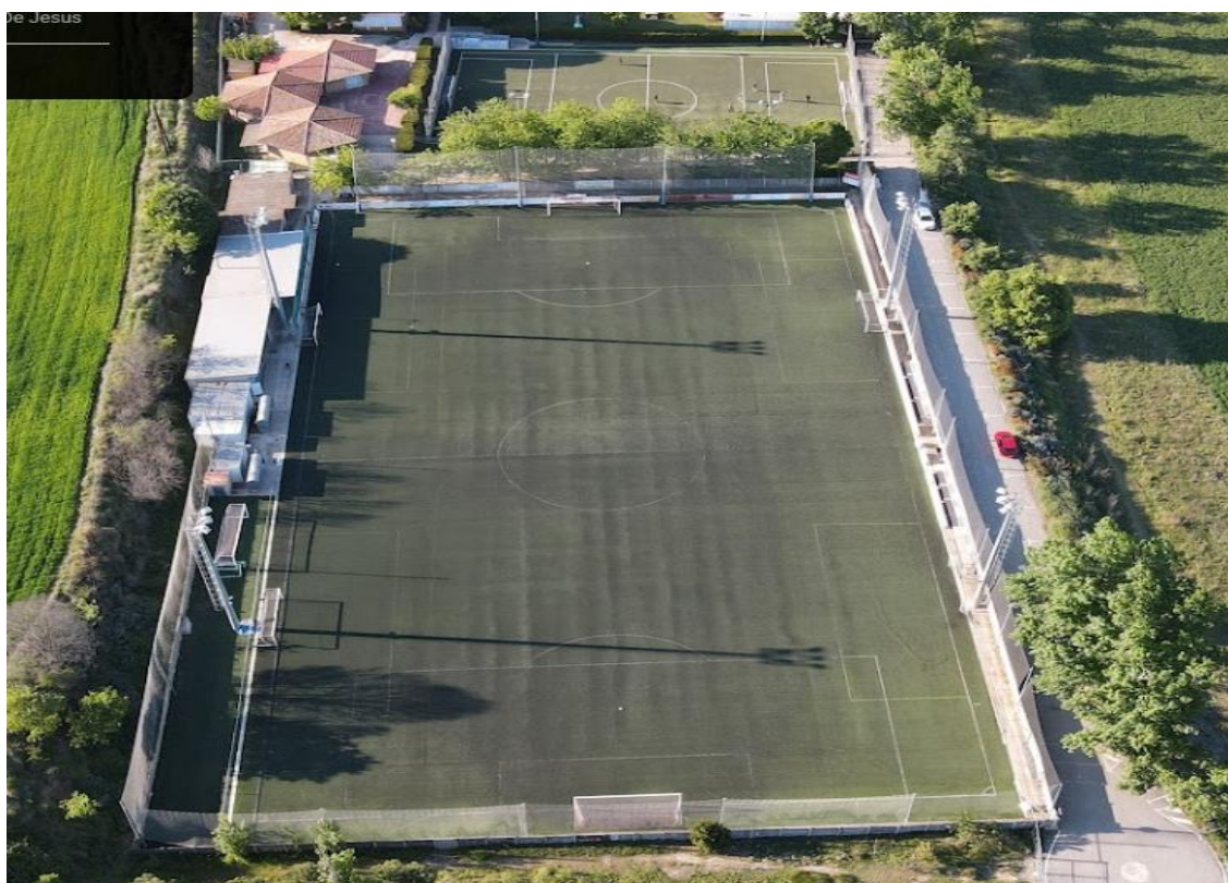
Annex 1 detall del camp de Juan Bocanegra (Barri de Lourdes)
