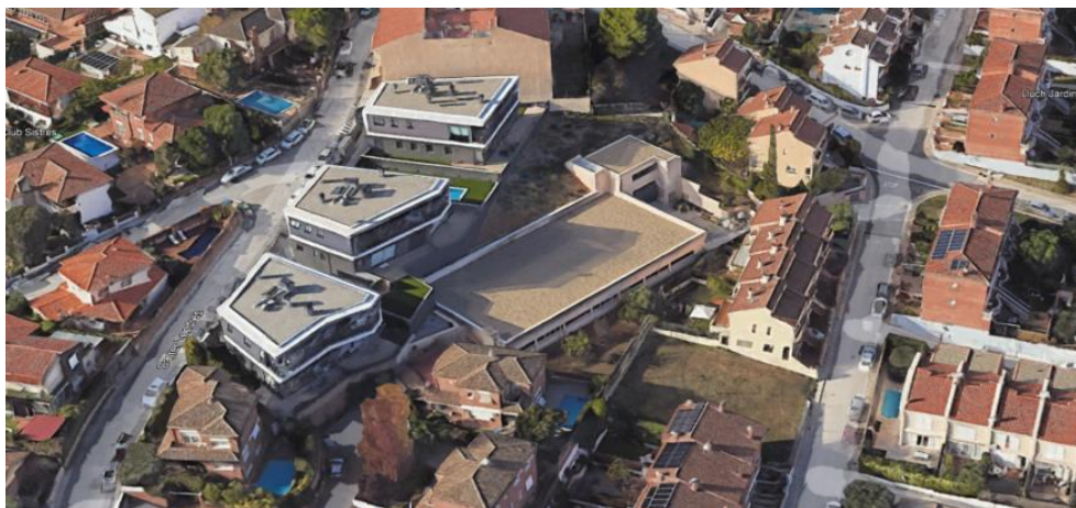
Figura 3. Imatge de l'edifici de la Brigada, on s'instal·len els panells.
