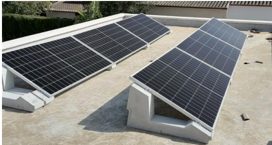
Figura 7. Fotografia dels elements estructurals.
