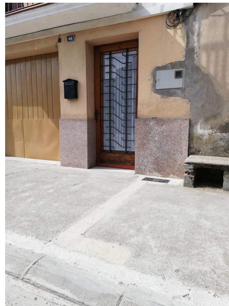
10. Carretera de Balaguer. Es veu l'escomesa i per on arriba la canonada.
