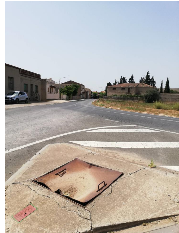
2. Arqueta a l'entrada del nucli per la LV 3231 venint d'Agramunt. D'aquest punt es fa la distribució cap al nucli de La Guàrdia.
