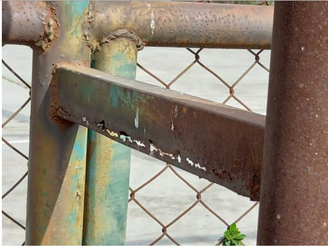
Detall de l'estat del tancament perimetral parapilotes
