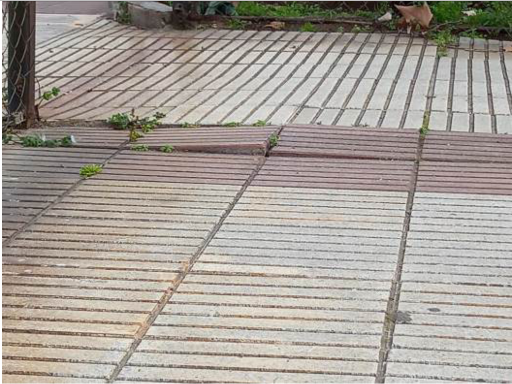
Detall del paviment del paviment perimetral de terratzo
