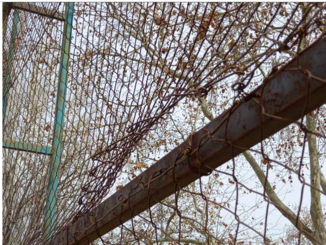
Detall de l'estat del tancament perimetral parapilotes
