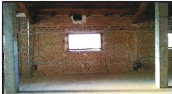
Fotografia 2: Vista zona inferior realització prova
