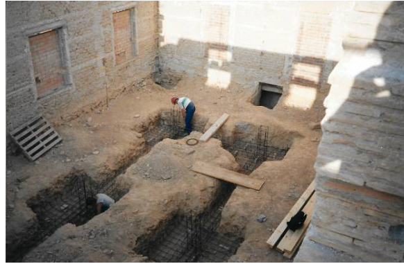
Excavació i nova fonamentació interior
