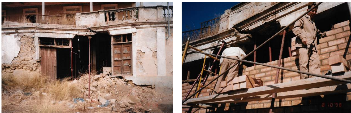
Estat inicial en el tram de mur esfondrat, i nova construcció de mur de suport
