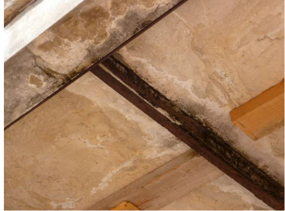
Sostre del porxo apuntalat per la degradació dels elements estructurals
