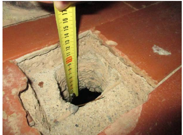
Detall de la llosa del sostre de planta baixa
