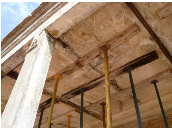
Armadura interior de la llosa corroïda
