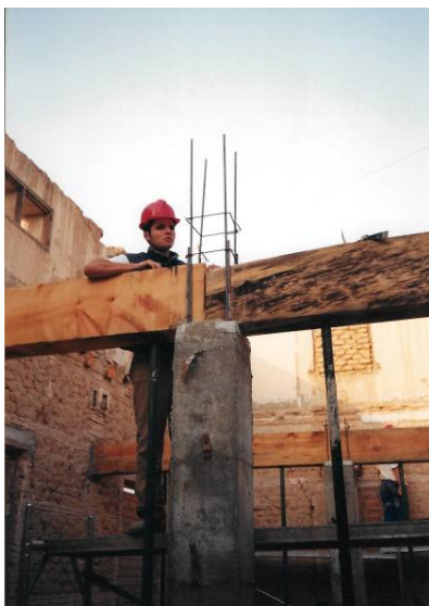
Col·locació de l'embigat de fusta asserrada del sostre de planta baixa
