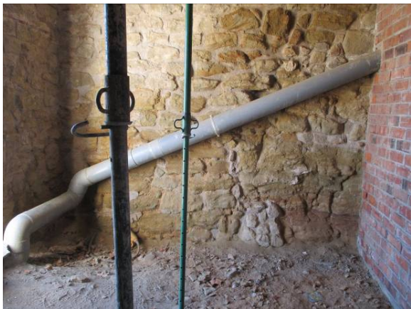
Detall dels laterals de la planta per on s'ha disposat el sanejament del cos principal
