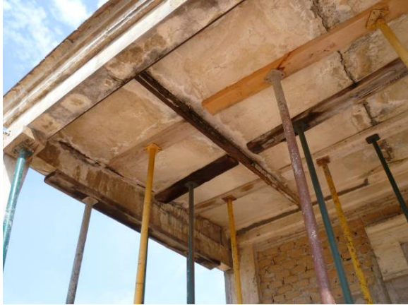
Sostre del porxo apuntalat per la degradació dels elements estructurals
