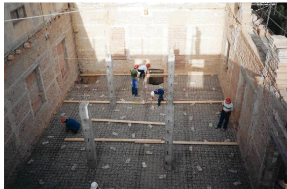
Pilars centrals i execució de paviment de planta baixa
