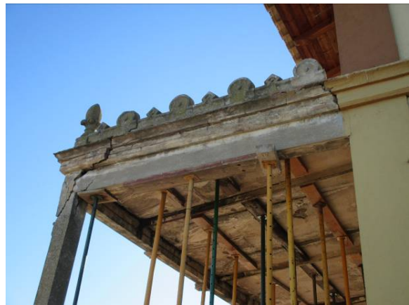
Detall de les restes de l'element decoratiu lineal de coronament
