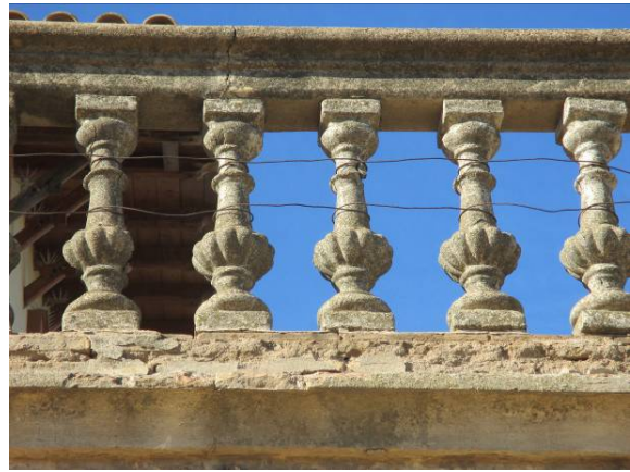
Planta semisoterrani i porxo de planta baixa. Detall de barana de balustres prefabricats
