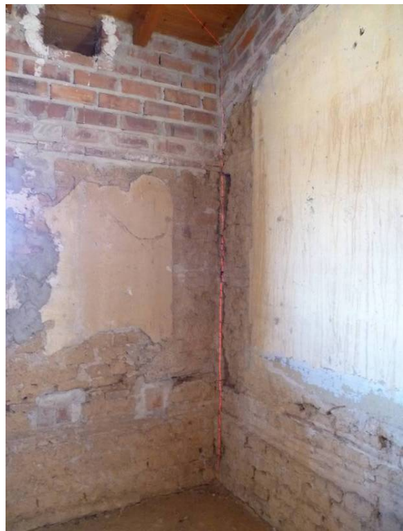
Comprovació de desploms en cantonades de planta baixa i primera
