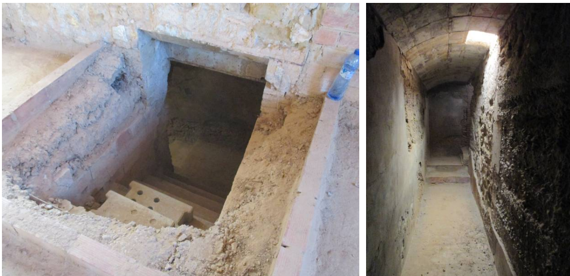
Accés al pas soterrat des de la planta baixa
