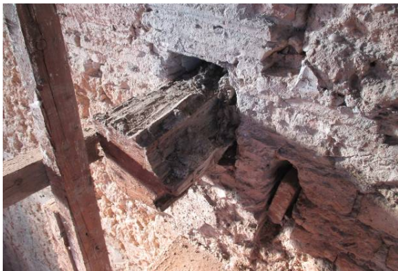
Caps de biga de l'edificació original que cal retirar
