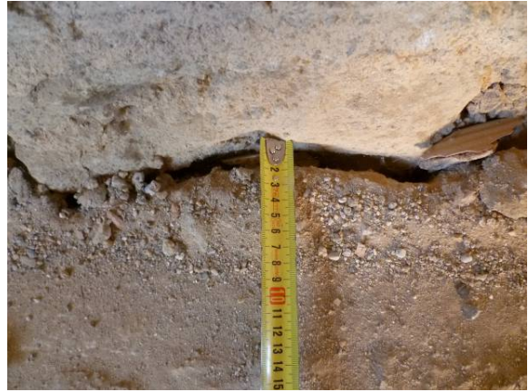
Separació de la façana respecte del paviment de planta baixa
