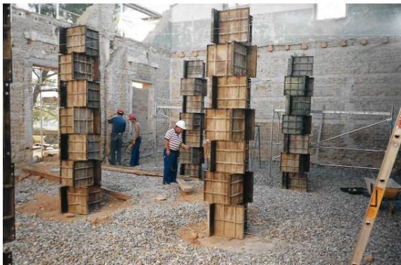
Pilars centrals i execució de paviment de planta baixa
