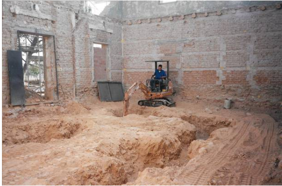
Excavació i nova fonamentació interior
