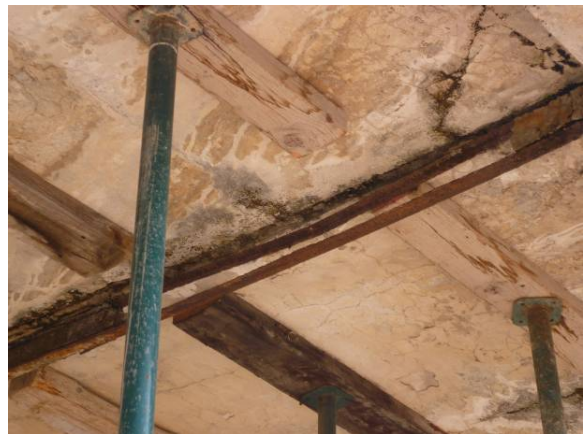
Biguetes metàl·liques sense ànima per corrosió per efecte de l'humitat de filtració durant molts anys
