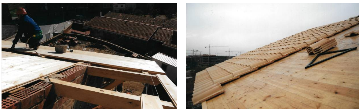
Muntatge de nova coberta de les mateixes característiques que l'original
