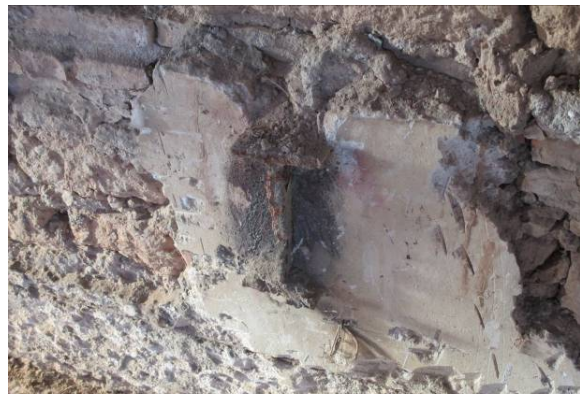
Caps de biga de l'edificació original que cal retirar
