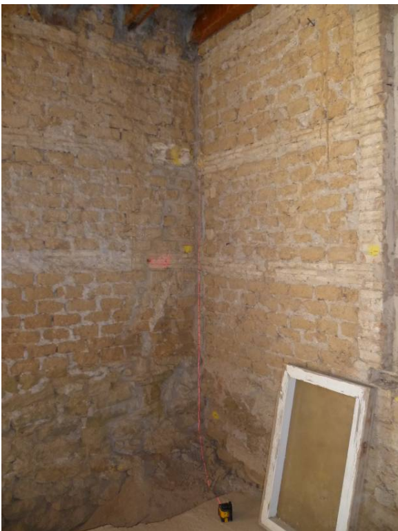
Comprovació de desploms en cantonades de planta baixa i primera
