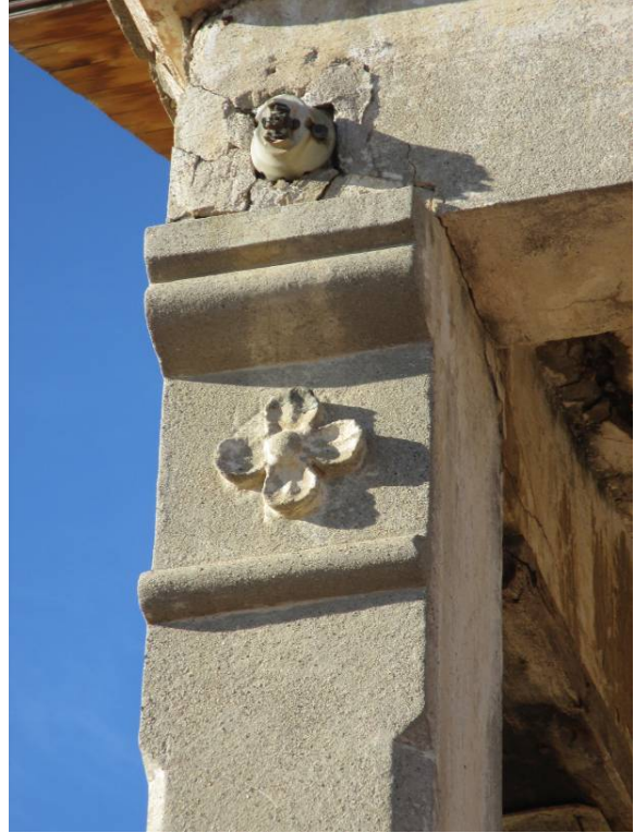
Vista oest del porxo i detall del remat del pilar prefabricat
