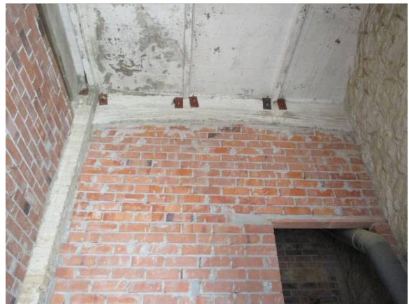
Detall dels laterals de la planta per on s'ha disposat el sanejament del cos principal
