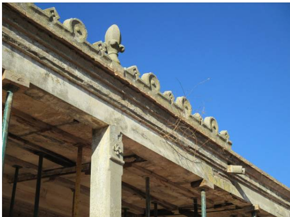
Detall de les restes de l'element decoratiu lineal de coronament
