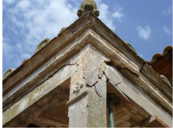
Vista general del porxo i terrassa, i detall de l'estat de degradació de la cantonada superior del porxo
