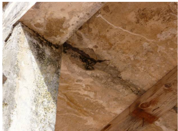
Armadura interior de la llosa corroïda
