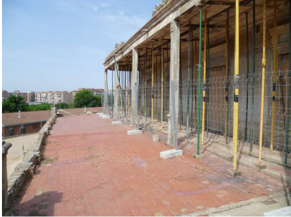
Vista general del porxo i terrassa, i detall de l'estat de degradació de la cantonada superior del porxo
