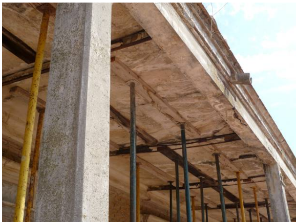
Biguetes metàl·liques sense ànima per corrosió per efecte de l'humitat de filtració durant molts anys
