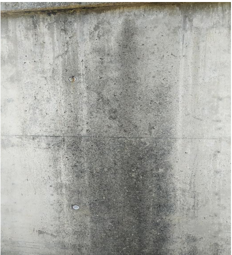
Fotografia 3. Detall del mur exterior del dipòsit
