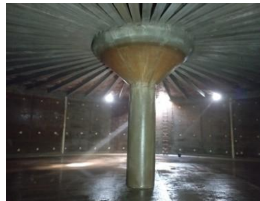
Fotografia 6. Pilar central on descansen les plaques prefabricades de formigó i les bigues (Agbar)
