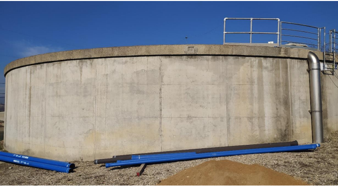
Fotografia 1. Vista general del dipòsit
