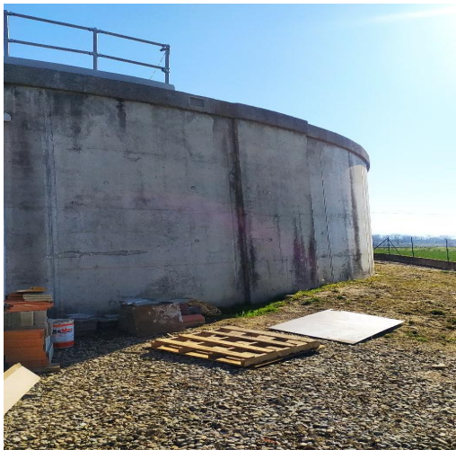
Fotografia 4. Exterior del dipòsit
