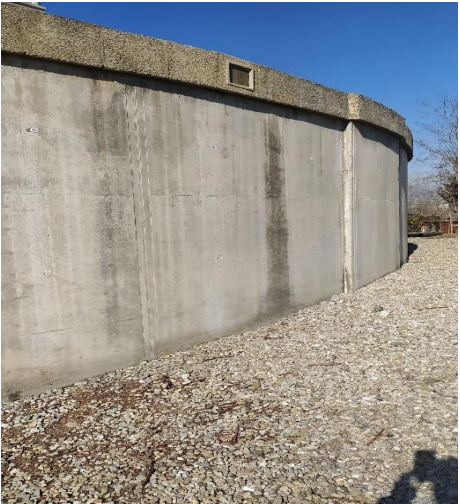
Fotografia 2. Exterior del dipòsit
