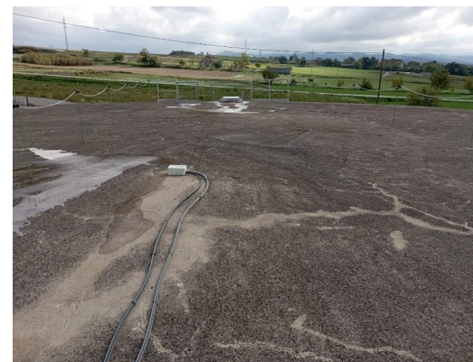
Fotografia 10. Vista de la coberta del dipòsit (Agbar)
