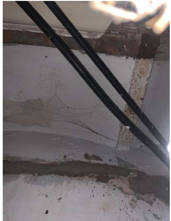
Bigueta metàl·lica forjat estructura coberta
