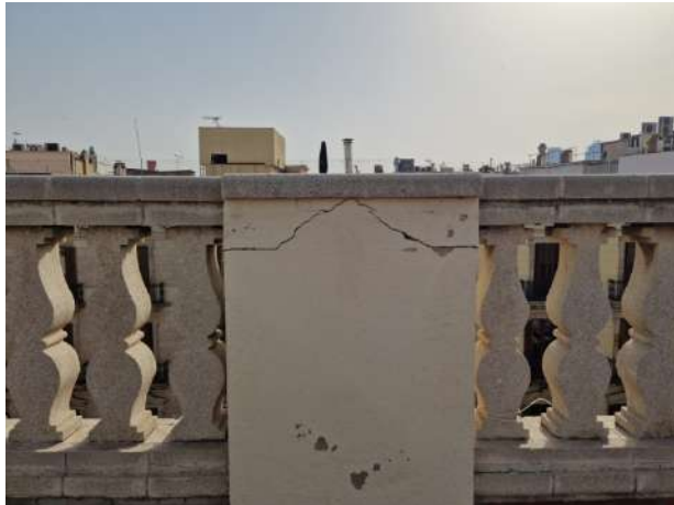
Balustrada al carrer Comerç
