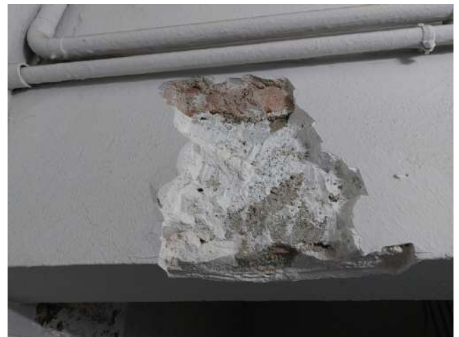
Jàssera de formigó armat que recull l'estintolament del mur de l'escala. Revestiment de guix.
