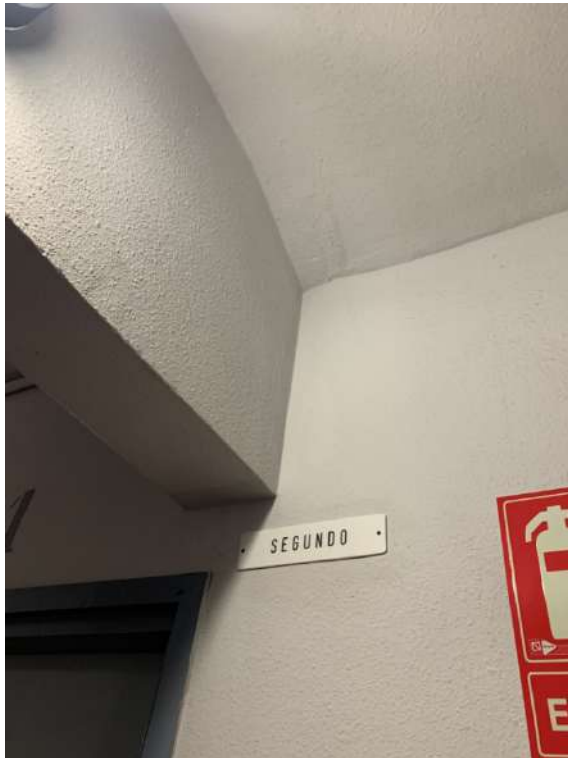
Punt on recolza el mur de càrrega.
