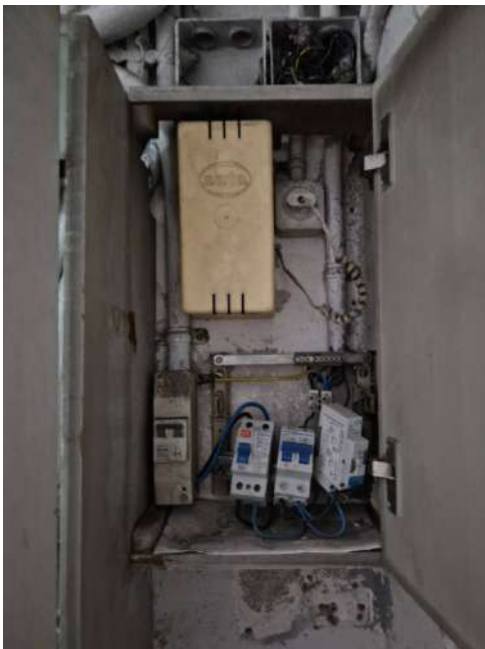
Instal·lació elèctrica vestíbul
