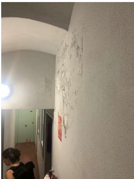
Mur de càrrega escala amb humitat i esquerra 1r pis
