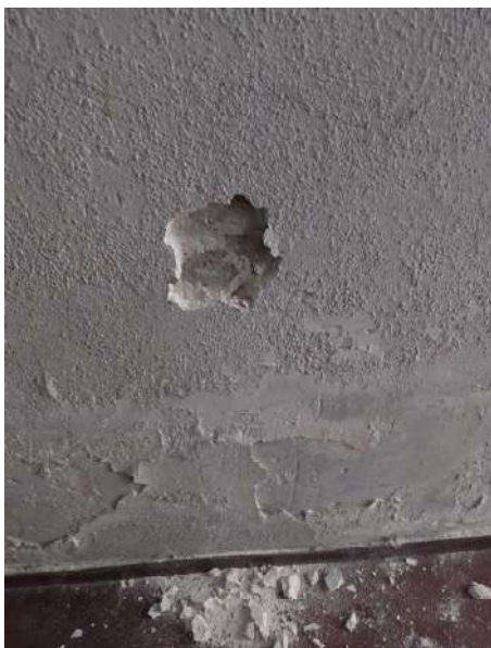
Vestíbul sota escala- revestiment de morter de ciment.
