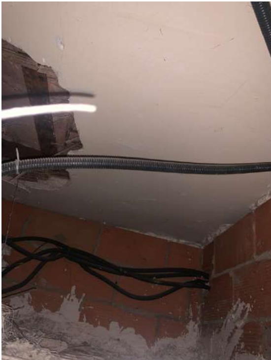
Registre al 3r3a on es veu estructura de coberta
