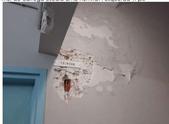
Cala realitzada al primer pis. Es constata que hi ha un tapiat d'una antiga porta.
