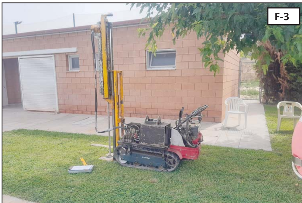
Fotografies 3: Detall de l'emplaçament de la màquina realitzant l'assaig de penetració dinàmica DPSH, P-3.
