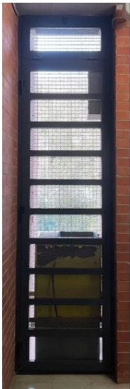
IMATGE DES DE L'INTERIOR DEL BASTIMENT F13.1 EXISTENT.
