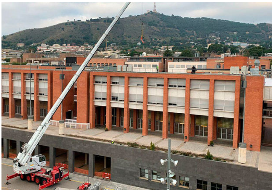
Imatge exterior de la façana sud-est dels edificis DNA5 i DNA6
