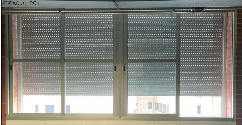
IMATGE DES DE L'INTERIOR DEL BASTIMENT F01 EXISTENT.
