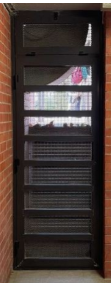
IMATGE DES DE L'INTERIOR DEL BASTIMENT F04.1 EXISTENT.
