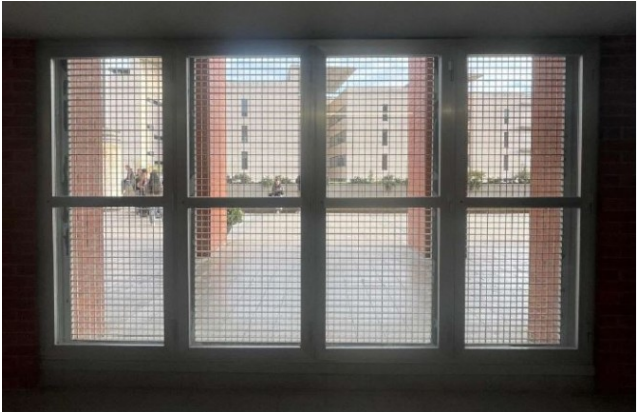
IMATGE DES DE L'INTERIOR DEL BASTIMENT F02 EXISTENT.
