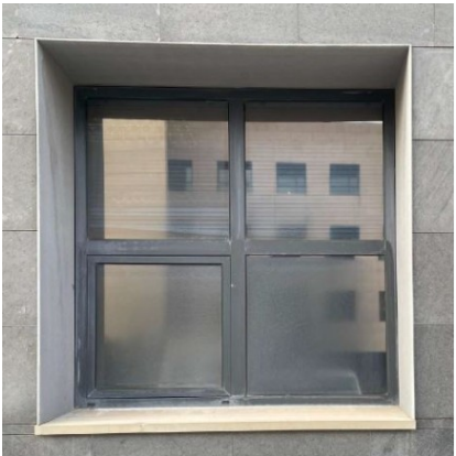
IMATGE DES DE L'EXTERIOR DEL BASTIMENT F04 EXISTENT.
