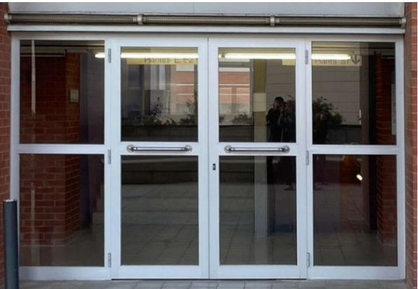
IMATGE DES DE L'EXTERIOR DEL BASTIMENT F03 EXISTENT.
