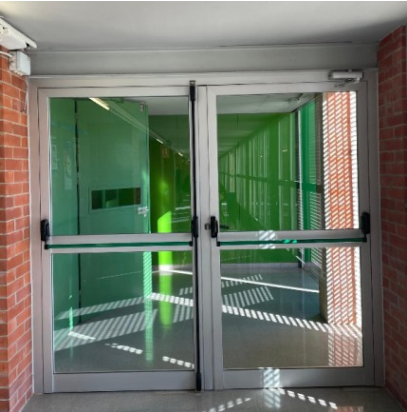
IMATGE DES DE L'EXTERIOR DEL BASTIMENT F03 EXISTENT.
