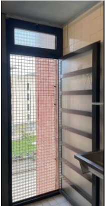
IMATGE DES DE L'INTERIOR DEL BASTIMENT F04.1 EXISTENT.
