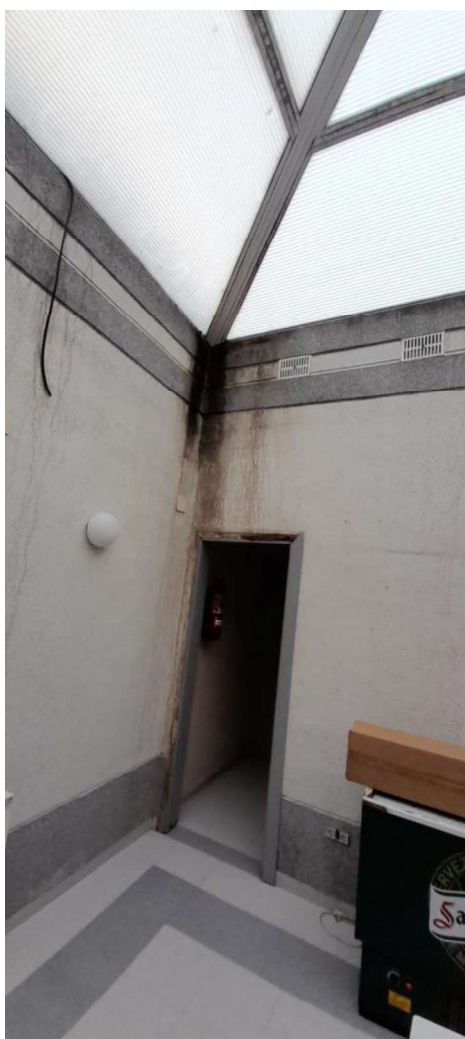
Imatge de porta accés sala d'actes i detall humitat de sostre
