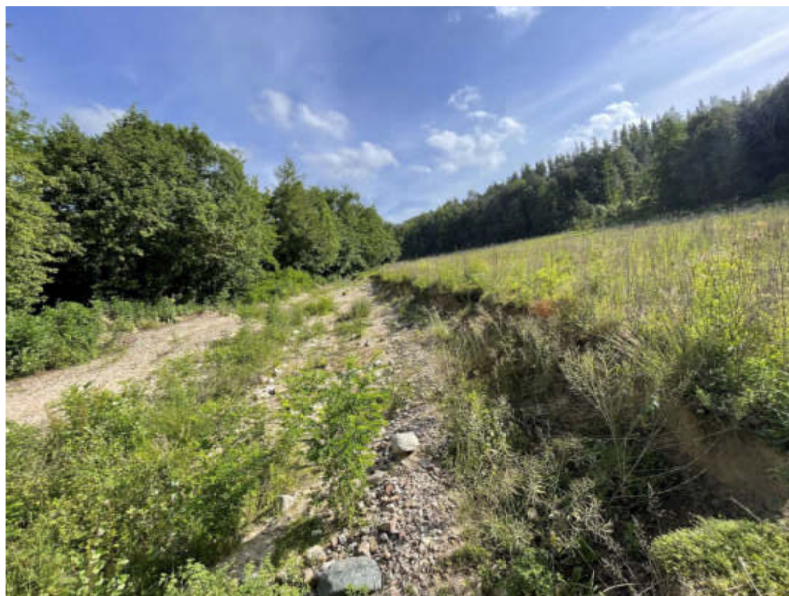
Fig. 14. Escarpament d'erosió lateral generat durant el temporal Gloria, paral·lel al curs de la riera , a una distància d'entre 15 i 20 metres, amb un metre d'alçada i 75 metres de longitud..
