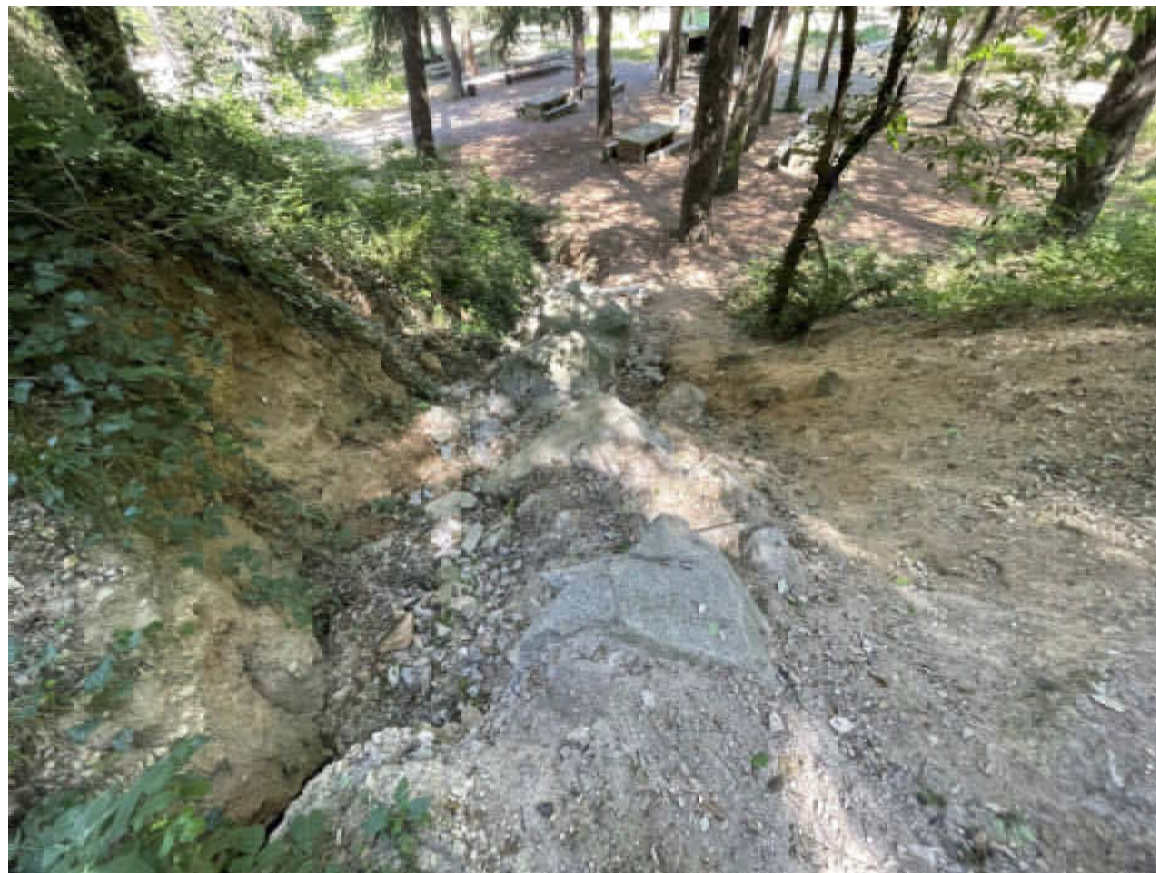
Fig. 49. El vessant situat als peus de la pedrera de les Gavarres presenta, en algun sector, rebliments antròpics que cobreixen el substrat. Aquests es troben altament degradats, amb fenòmens d'erosió superficial (solcs erosius i un cert xaragallament) que connecten amb la rasa de drenatge perimetral de l'àrea del Picnic La Riera d'Arbúcies, tal i com es pot veure a la imatge.
