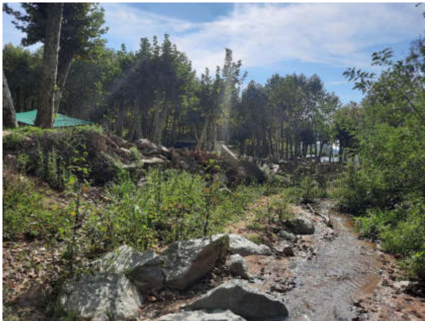
Mur d'escullera a la zona 3.3
