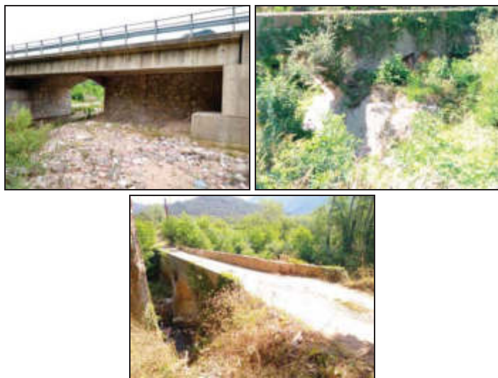
Fotografia 2, 3 i 4. Vista d'alguns dels ponts existents a la zona d'estudi.
