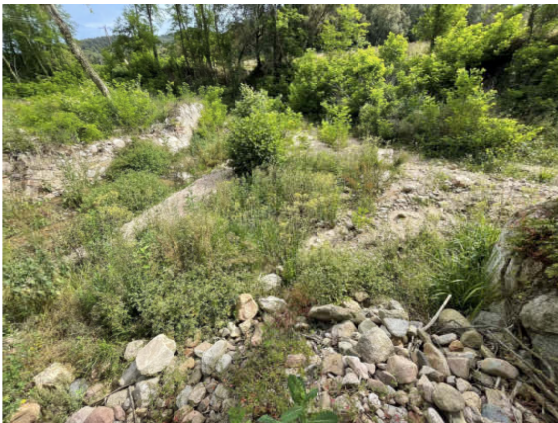
Fig. 2. Barra sorrenca recent amb còdols i blocs acumulats abans de creuar el pas d'accés a la masia la Casica. En aquest punt, el llit es troba limitat a banda i banda pel mur de pedra i un aflorament de substrat rocós granític.
