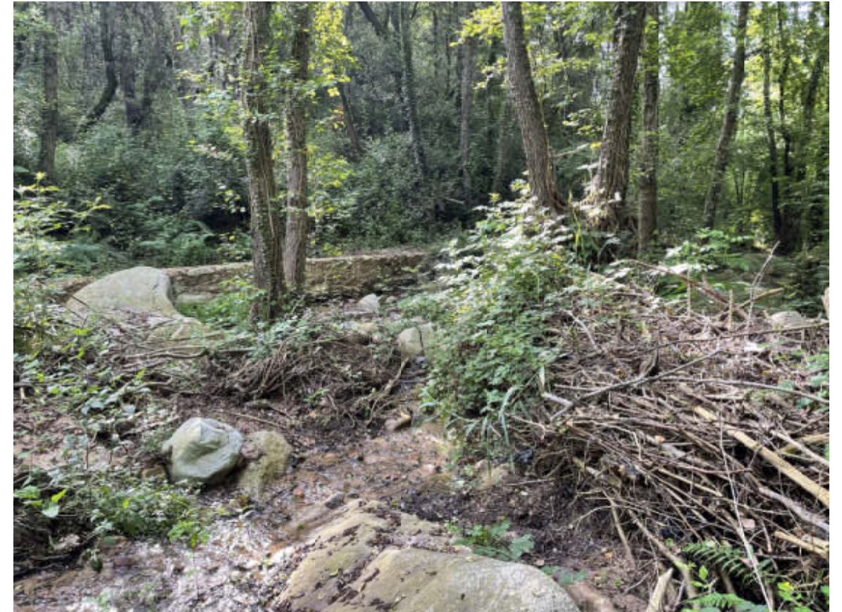
Fig. 19. Acumulació de sorres i flotants (branques) a la llera de la riera de la Pineda.
