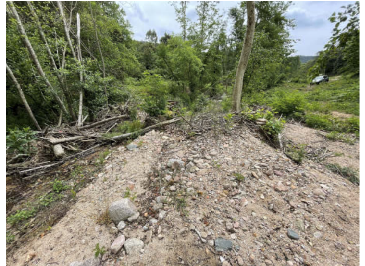
Fig. 23. Detall de l'important gruix de sediments sorrenços dipositats aigües avall del llindar rocós (veure fig.21), taponats o encallats per l'acumulació d'elements a la llera (troncs i branques, principalment).
