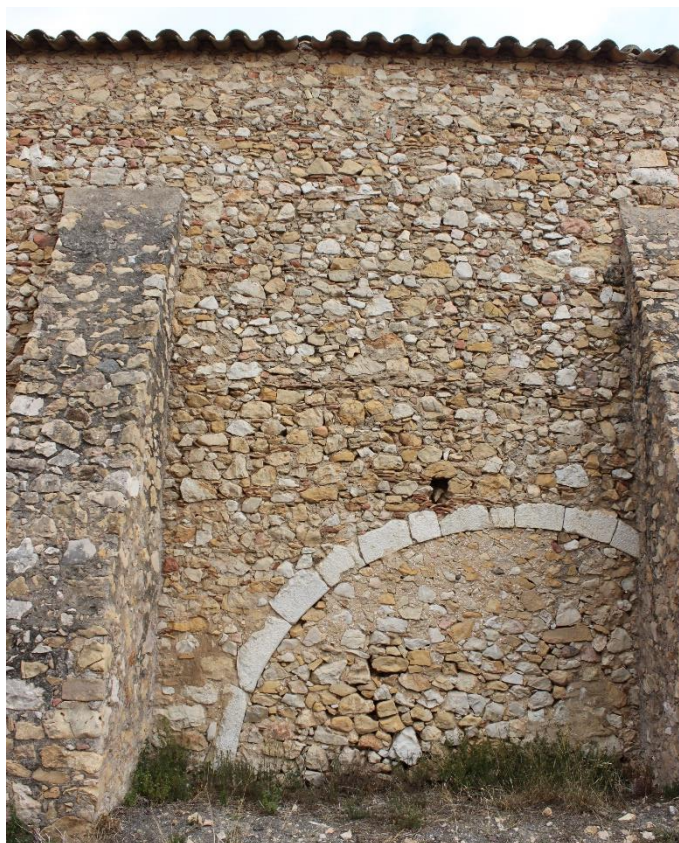
Contraforts i antigues obertures a la façana sud
