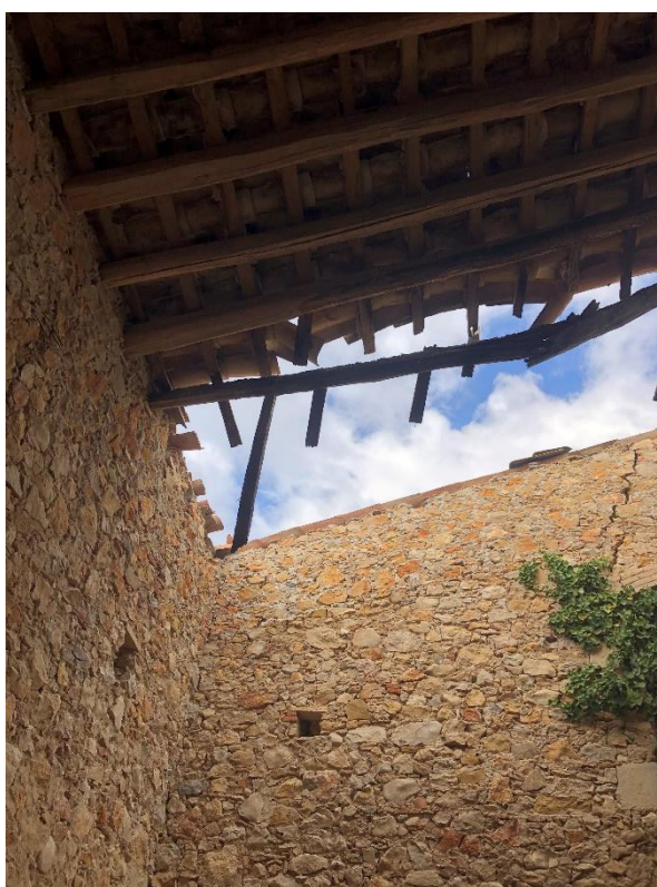
Part de l'edifici sense sostre
