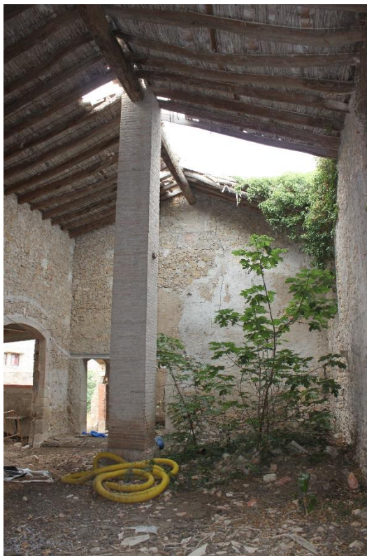
Part de l'edifici sense sostre
