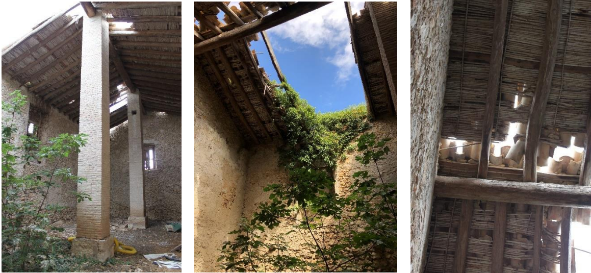
Vista de l'espai interior del cos est.
