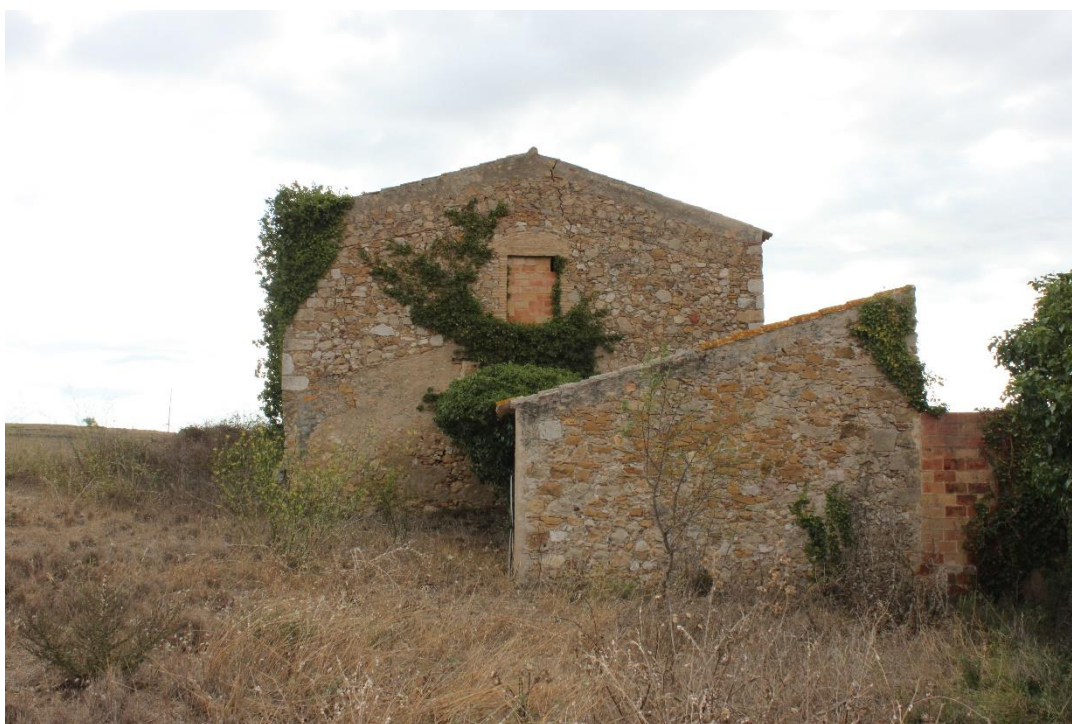
Façana est dels volums objecte de la intervenció
