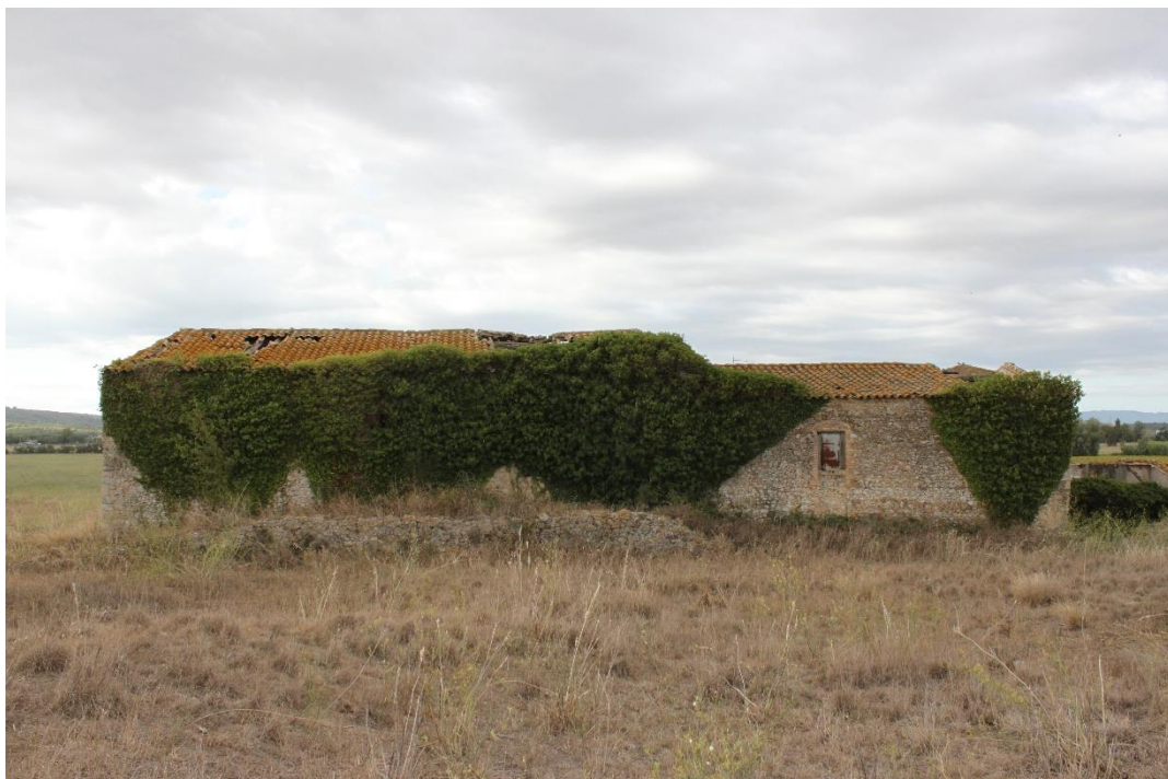
Façana nord dels volums objectes de la intervenció
