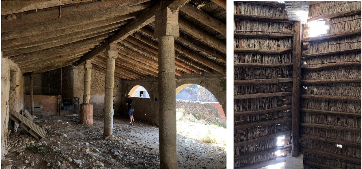
Vista de l'espai interior d'un dels edificis auxiliars i del sistema constructiu de la coberta.
