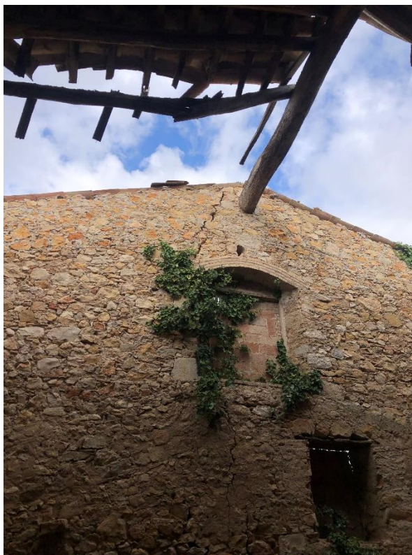
Part de l'edifici sense sostre
