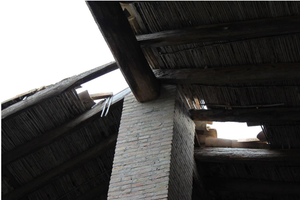
Detall de trobada del pilar ceràmic amb la coberta
