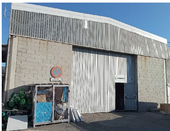
F1: Vista frontal del magatzem de manteniment
