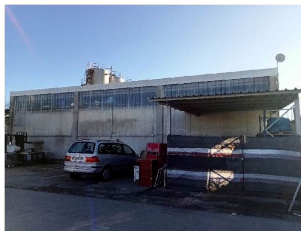
F2: Vista lateral del magatzem de manteniment
