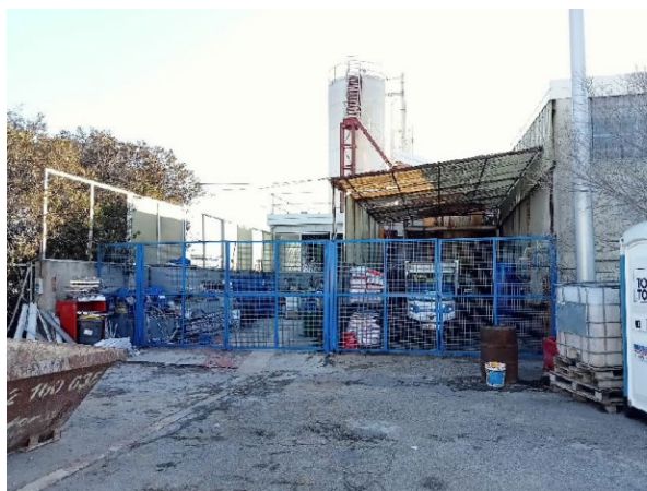
F3: Vista de la part posterior del EDAR
