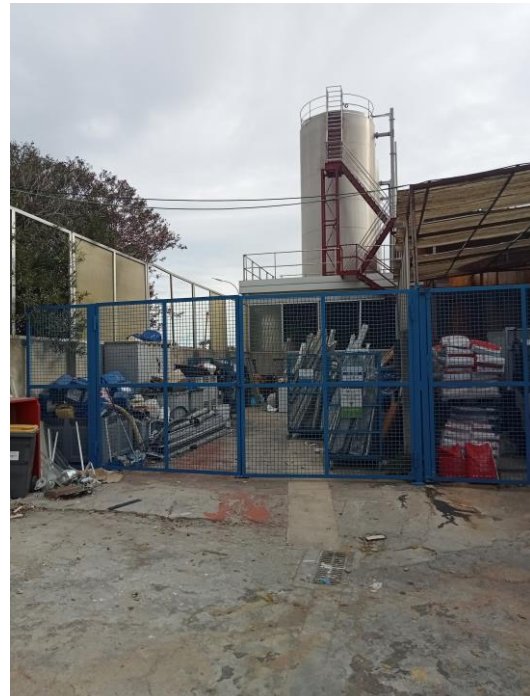
2. Part posterior a edifici existent, punt verd i EDAR al fons
