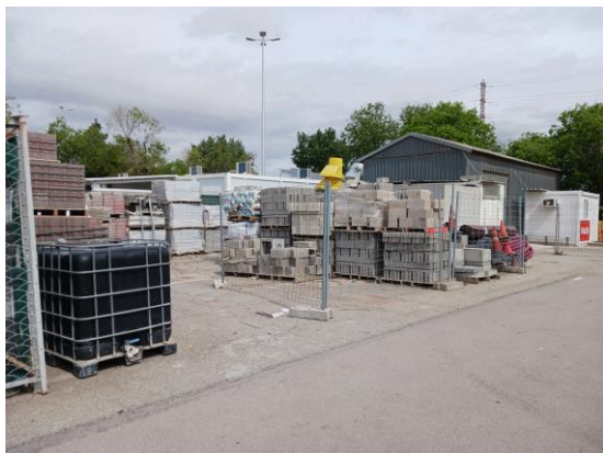
5. Campa d'obres i magatzem MAN existent
