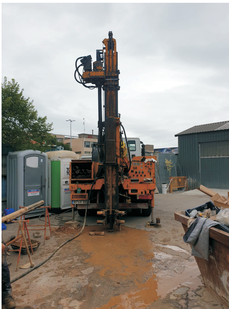
Fotografia 7. Execució del sondeig S-1R.
