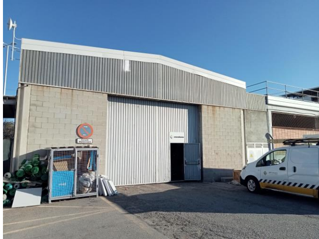
Fotografia façana principal edifici industrial existent
