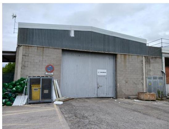
10. Façana principal edifici industrial existent amb EDAR
