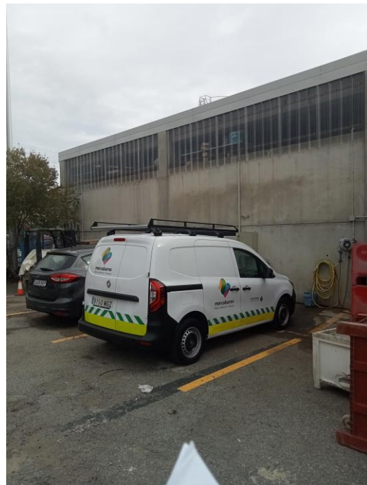
4. Lateral edifici existent prefabricat i aparcament exterior
