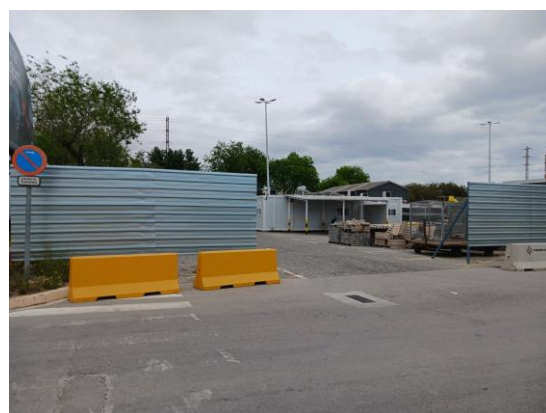
14. Vista des del carrer d'edifici provisional vestidors
