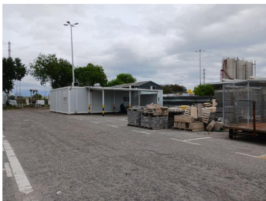
13. Edifici provisional barracons obra per vestidors i oficines
