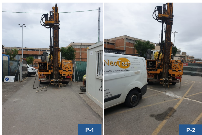
Figura 3. Execució dels DPSH P-1 i P-2.
