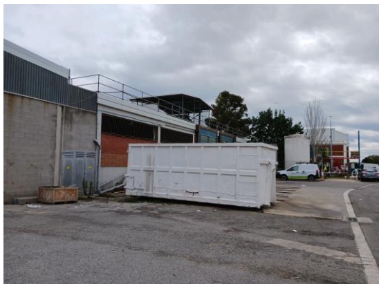
11. Edifici existent i EDAR, urbanització exterior
