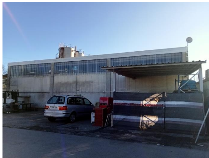
Fotografia façana lateral edifici industrial existent
