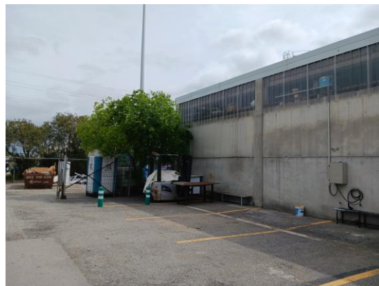
6. Lateral edifici i arbrat afectat a trasplantar
