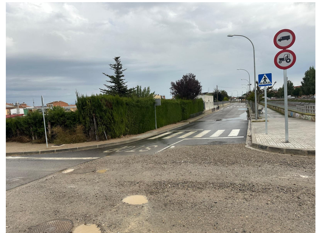
Foto 5.- Final de l'actuació. Avinguda del Carrilet
