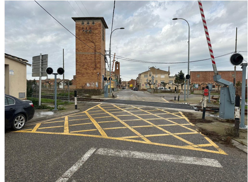
Foto 4.- Creuament del ferrocarril del carrer Estació
