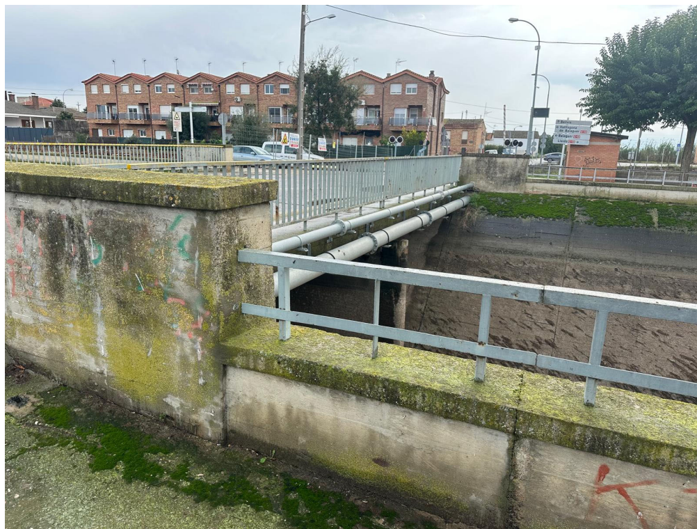
Foto 3.- Creuament del canal del carrer Estació
