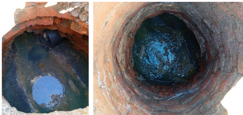
Figura 3. Estat dels pous de registre.
