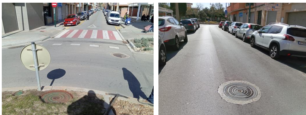
Figura 4. Estat superficial sobre l'àmbit d'actuació.
