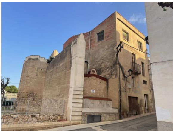
Muralla amb el carrer de la Costa 34.
