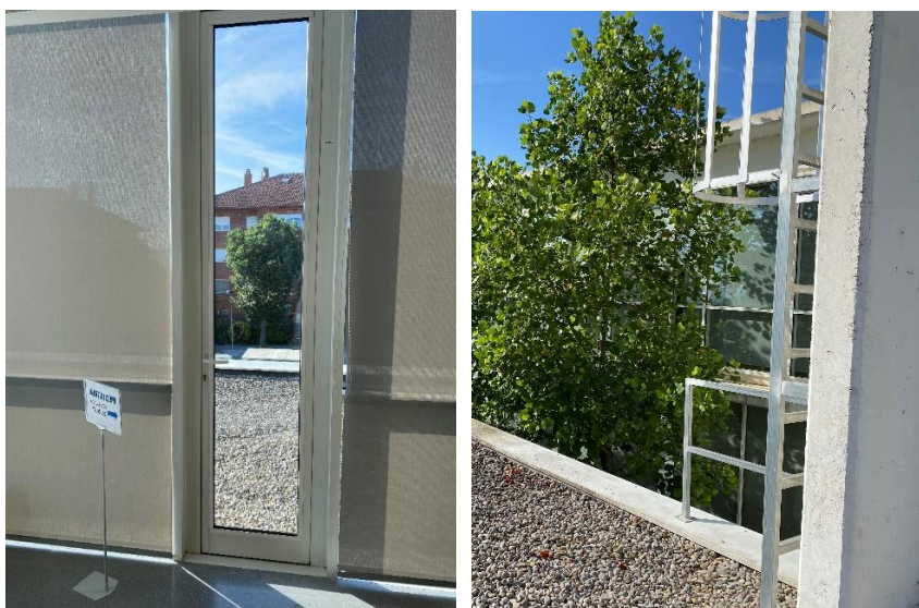
Accés a coberta 1 i 2 a través d'escapes existents
