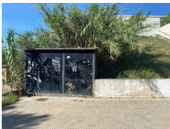
Armari exterior on s'ubica la TMF de consum i la CGP + CS
