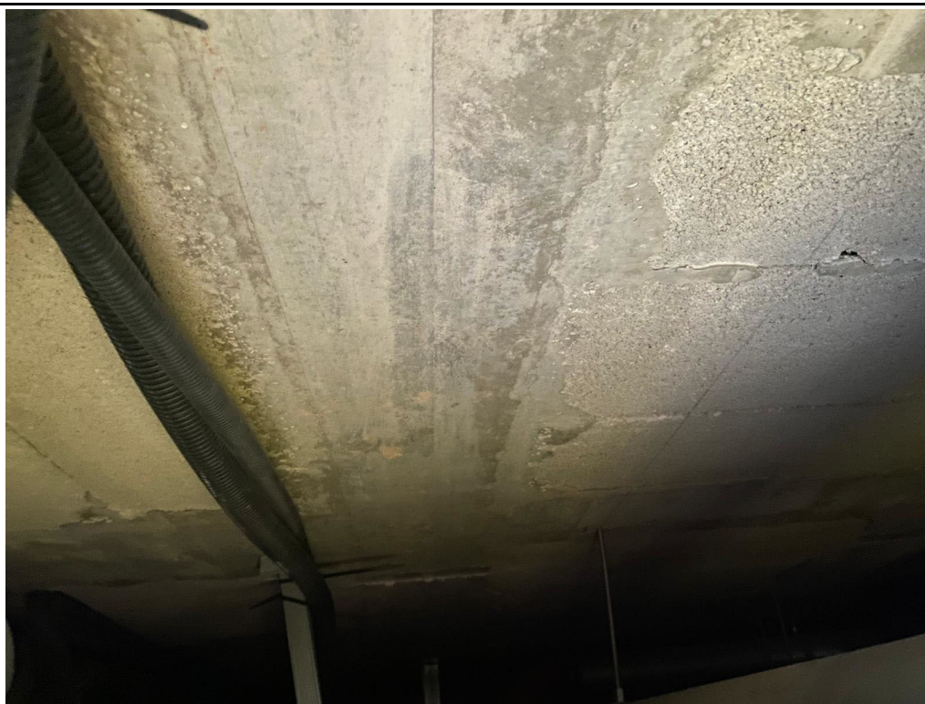
Figura 6 | Sector placa de cubierta
