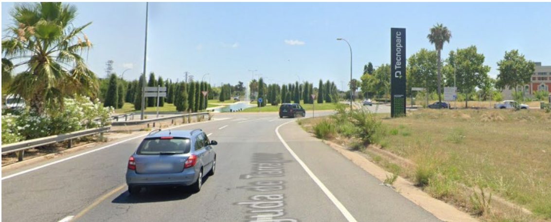
Il·lustració 11. Accés al Tecnoparc de Reus des de l'av. de Tarragona, sentit Reus - Tarragona.
