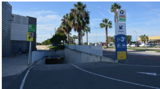
Imatge 19. Zona d'accés a l'aparcament de REDESSA Tecno.
