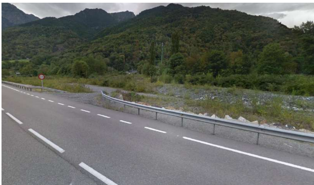
Imatge 28: Accés i camí existents a la zona de l'actuació
