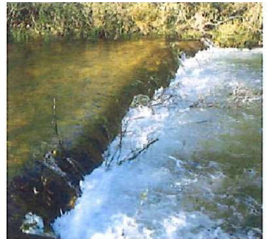
Imatge 2. Esquema de la forma i l'efecte de la construcció de travesses. Es generen conjuntament gorgs i fresadors.
