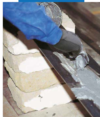
Aplicación de Adesilex PG1 sobre placa metálica
