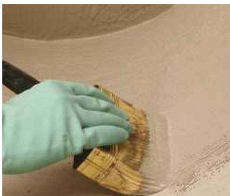
Impermeabilización de muro de cimentación a brocha
