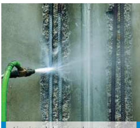
Limpieza de las armaduras con chorro de agua y arena.
