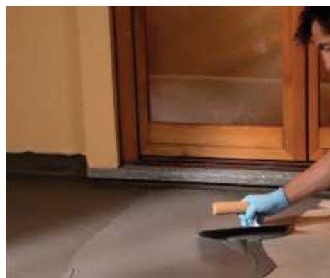
Impermeabilización de arqueta de hormigón a brocha
