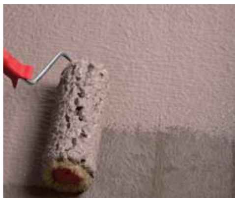
Impermeabilización de muro de cimentación a rodillo
