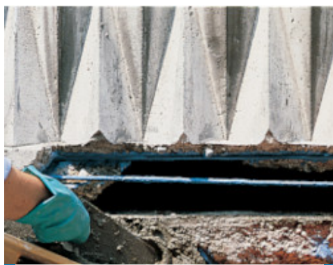
Ejemplo de reparación de un balcón con Mapegrout T40 SR , "fase inicial"
