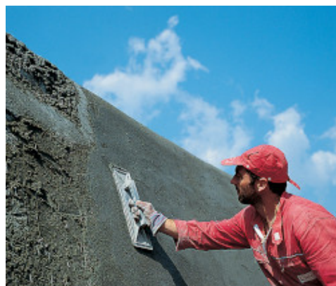
Acabado de Mapegrout T40 SR con fratas
