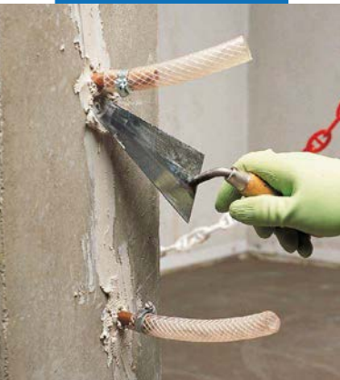
Fijación de tubos de inyección y estucado de las fisuras en consolidación estructural
