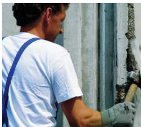
Demolición del hormigón degradado.
