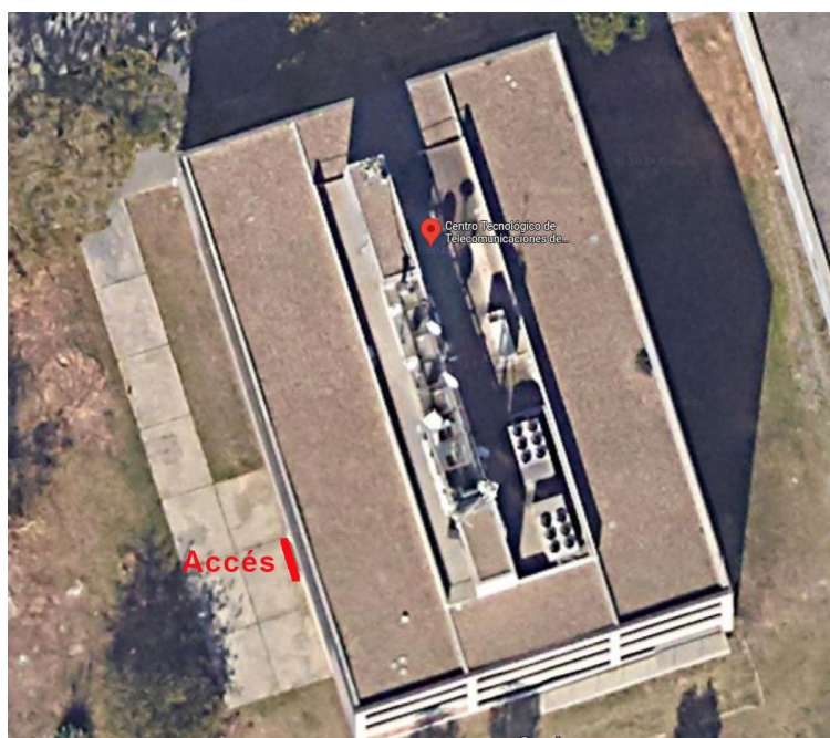
Figura 3 Accés extern per l'aparcament de l'edifici B4 a la sala del SAI
