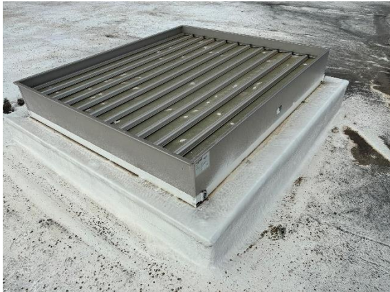
Exutori impermeabilitzat fins a xapa base
