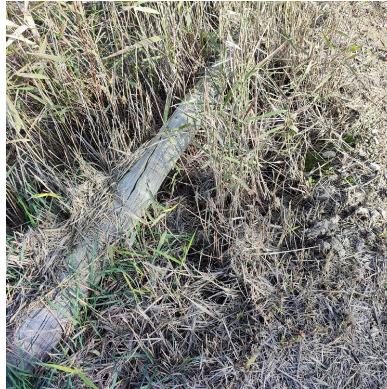
Post situat al marge del torrent del Prat.
