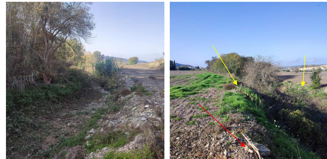
Fig 17. Imatges d'ocupació. A l'esquerra, conreus situats al voltant del Pk 1+700; A la dreta, ocupació al Pk 2+900. En aquest segon cas, s'observa ocupació per totes dues marges (fletxes grogues). També s'observa la presència de restes de residus de la construcció (fletxa vermella).
