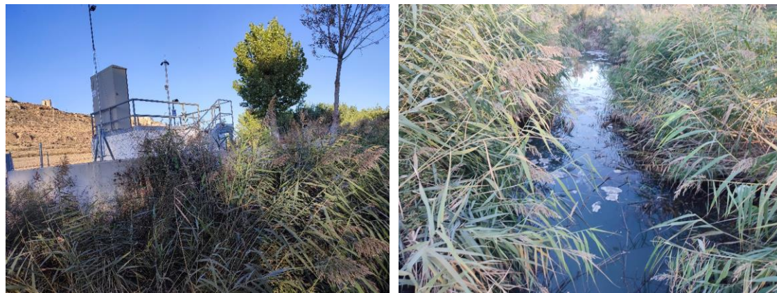
Fig 28. Imatges de l'estació de bombament i estat de les aigües després d'un abocament
