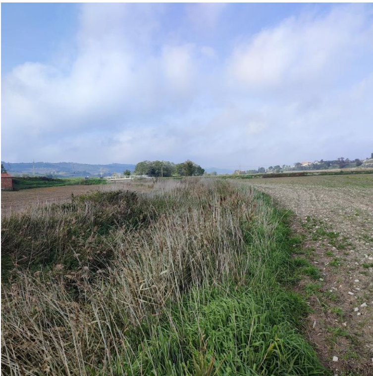
Entre pont LV-3031 i pont L-203 (0+800). L'estructura és molt semblant. S'observa un increment del fenassar al costat del marge.
