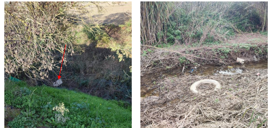
Fig 31. A l'esquerra, imatge del tram proper a Sant Pere dels Arquells. A la dreta, neumàtics a la llera, just passat el Molinet de Cervera (entre Pk 10+700 i 10+900)
