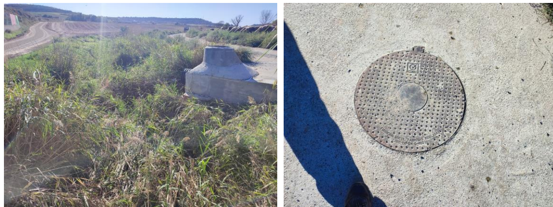
Fig 29. A l'esquerra, imatge de sobreeixidor al Pk 7+900; a la dreta, imatge de la conducció del col·lector sota el camí paral·lel al riu al Pk 8+340
