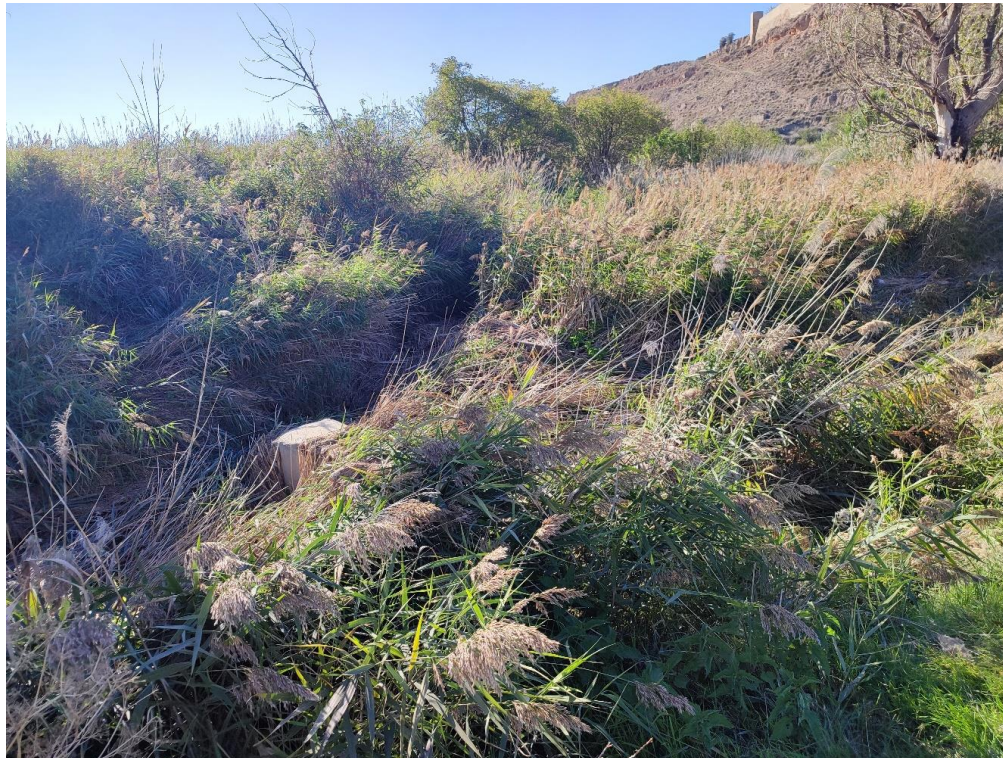
Tram fluvial al Pk 8+140. En aquest punt s'observa una petita resclosa. En aquest punt el DPH es fa molt més ample.
