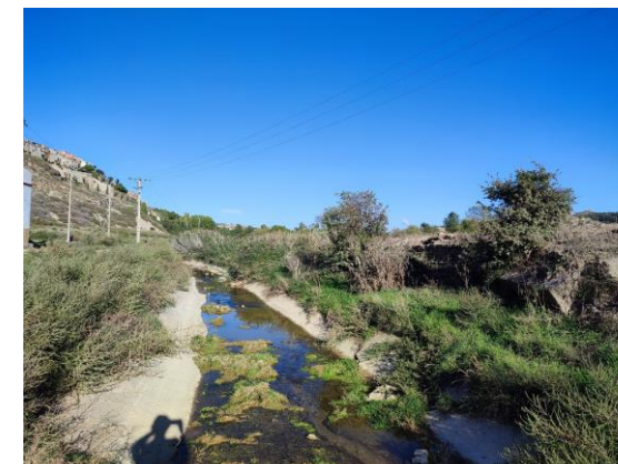
Fig 21. Tram de llera artificialitzada i endegada
