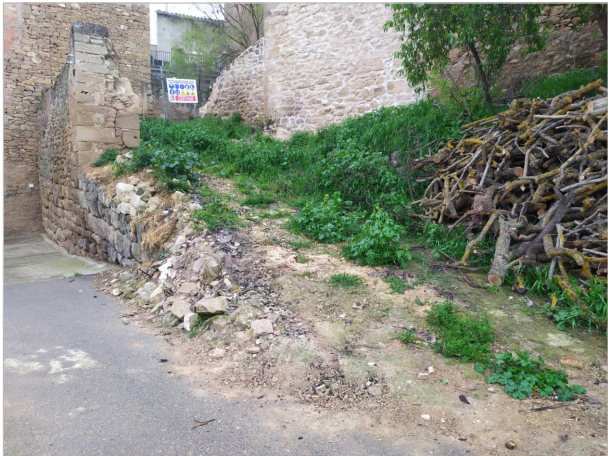
Acces carrer interior. Foto D
