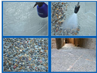
Paviment de formigó i Arid vist (TQ desactivador H Tecnor)
