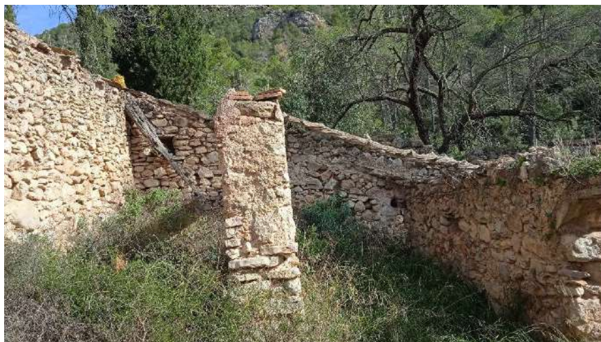
Pati interior del corral on cal reforçar pilars abans de construir estructura de forjat i teulada.
