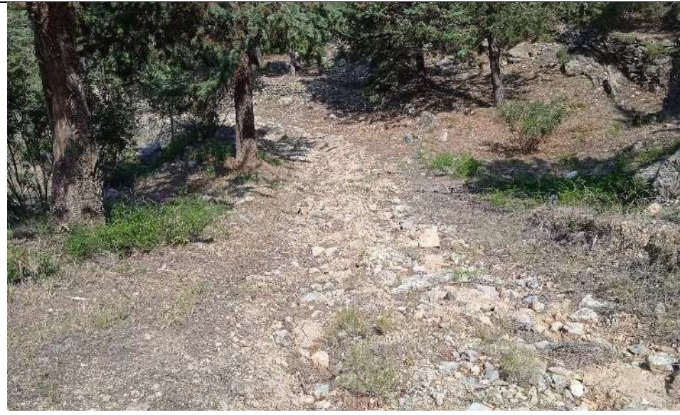
Tram de pista d'accés als bancals malmès per l'aigua
