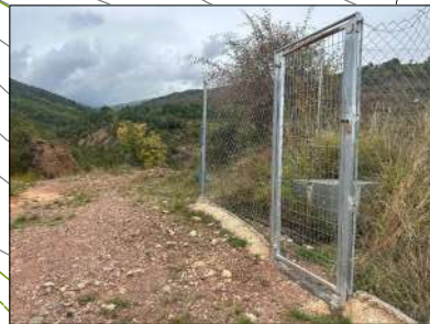
Imatge 03. Dipòsit metàl·lic acumulació existent
