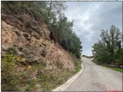
Imatge 05. Canonada aèrea costat carretera
