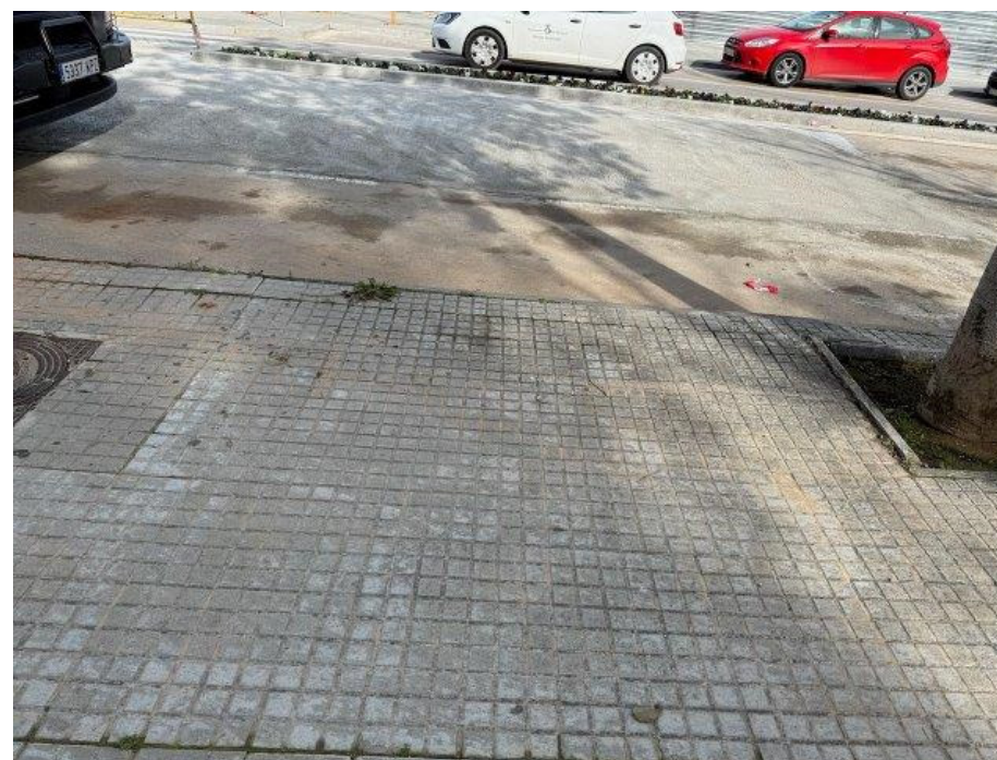
Foto 5 – sector Les Bòbiles Oest
