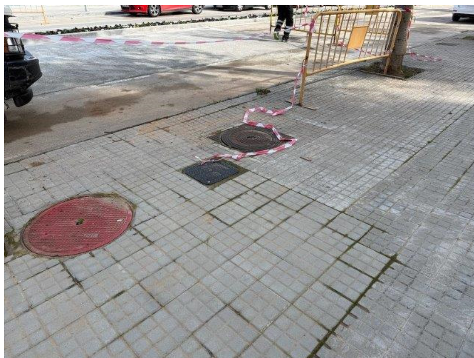
Foto 4 – sector Les Bòbiles Oest
