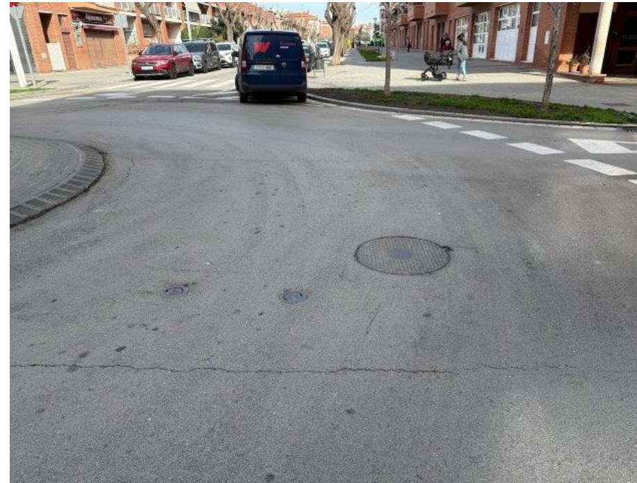
Foto 8 – sector Les Bòbiles Oest
