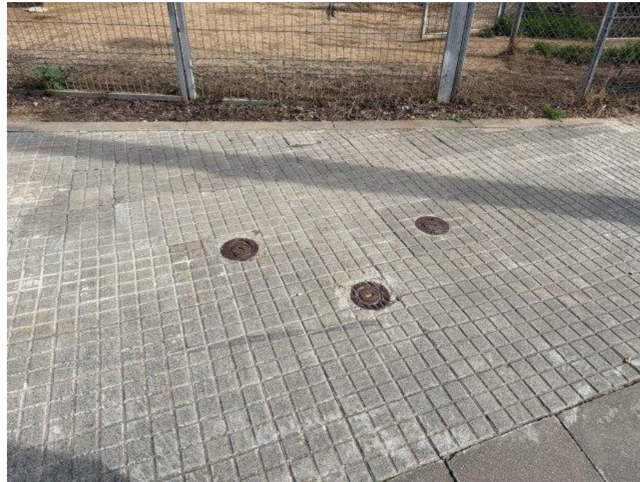
Foto 7 – sector Les Bòbiles Oest
